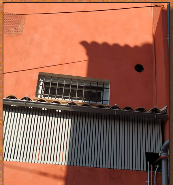
Dissimulation de deux unités extérieures en applique sur des façades. EN HAUT : dans la vitrine de la Caisse d'Épargne, Chemin Neuf. EN BAS : façade Calade Saint-Roch à l'angle du Chemin Neuf.
