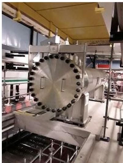
Figure 7. Photo arrivée échangeur EAS-ND
