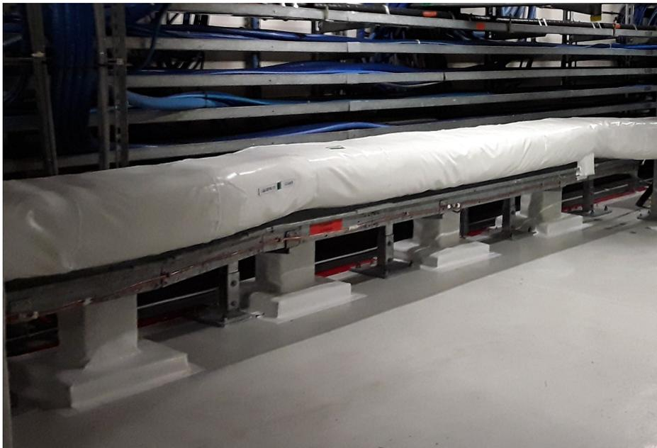
Figure 6. Exemple de protection de chemin de câble
