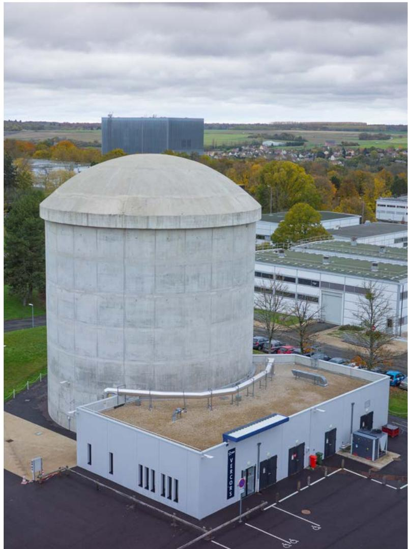
et la fuite des enceintes ; il est ouvert à la communauté scientifique et technique mondiale. Il permet d'améliorer les modèles numériques, de développer de nouvelles technologies de détection de fuite, de contrôles non destructifs du génie civil (détection de la corrosion, des défauts du béton...). L'expérimentation confirme également que la tenue structurelle des enceintes dispose de marges importantes.
