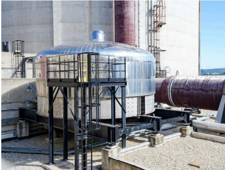
Figure 14. Photo du dispositif d'éventage et de filtration de l'enceinte (filtre U5)
