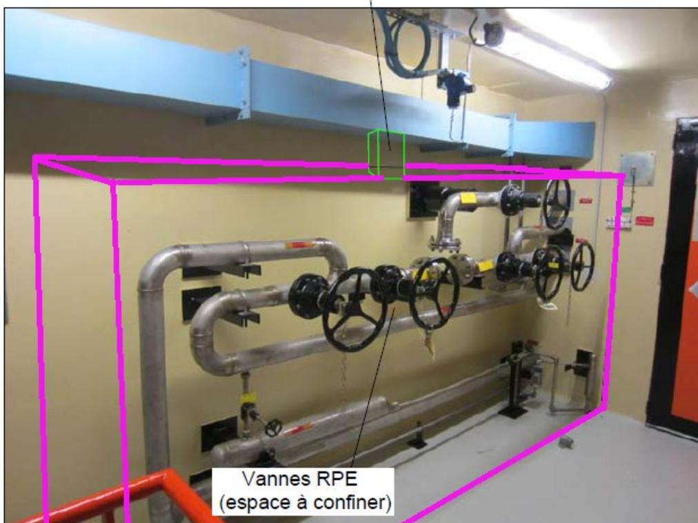
Figure 21. Exemple d'une enceinte ventilée raccordée à la filtration iode autour de certains équipements du système de collecte des effluents de l'îlot nucléaire (RPE)
