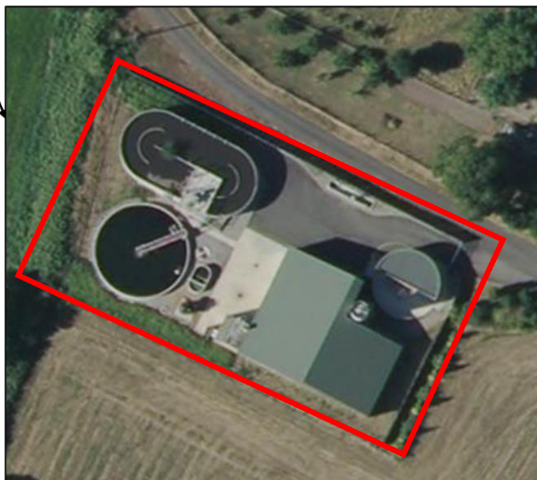
Figure 5: Station de traitement des eaux usées
