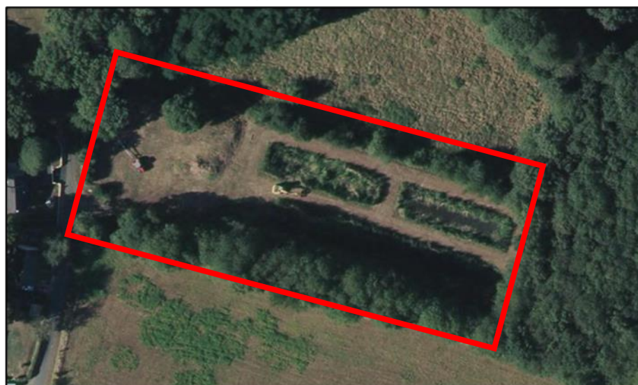
Figure 7: Station de traitement des eaux usées du secteur Vieux Bourg
