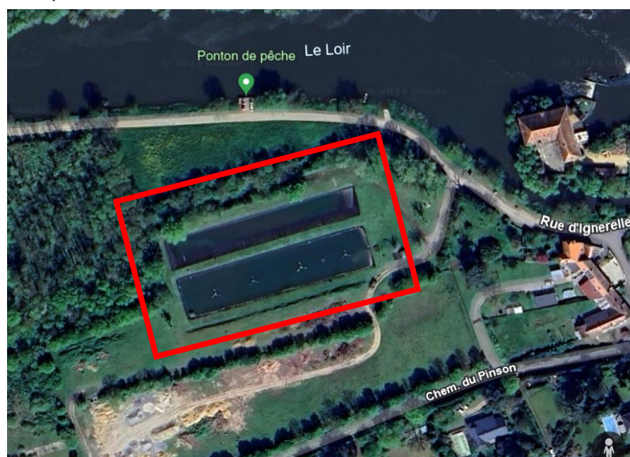
Figure 5: Station de traitement des eaux usées
