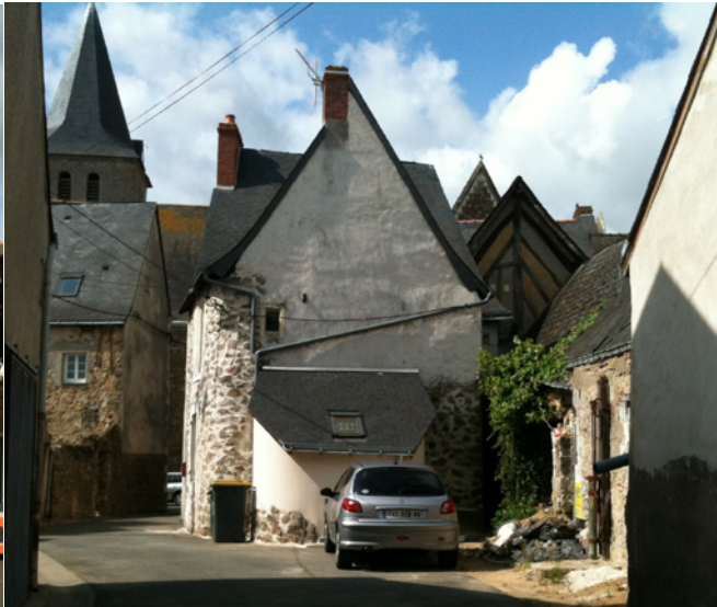
Arrière de l'église Saint-Hilaire depuis la rue du stade
