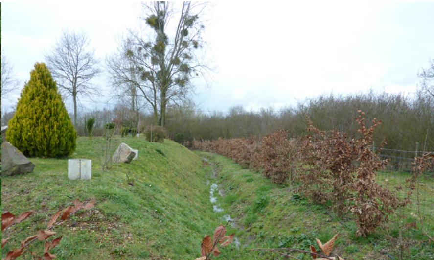
Fossé des eaux pluviales autour de la parcelle intégrant la mare d'agrément
