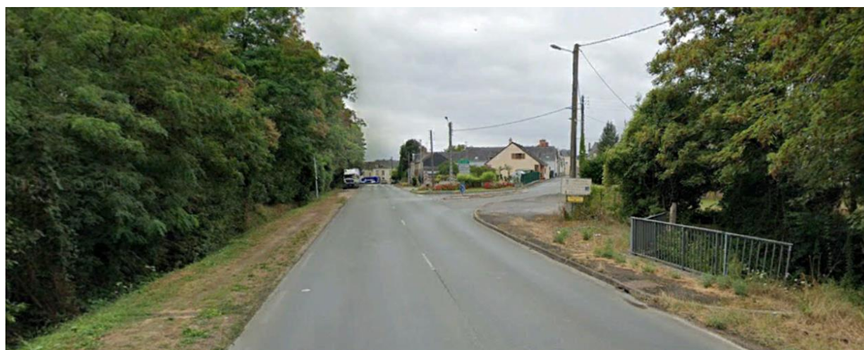
Le carrefour RD 766 (à gauche) / RD 74 (à droite) vue d'est en ouest sur la partie sud du secteur 2AU
