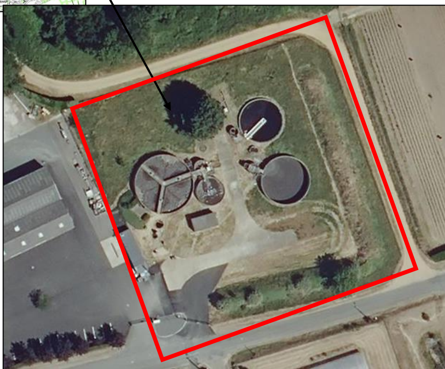
Figure 5: Station de traitement des eaux usées
