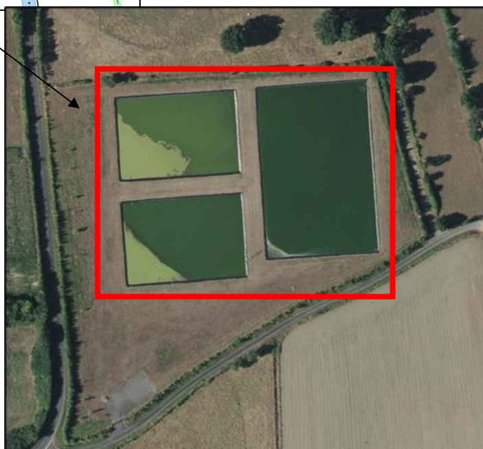
Figure 5: Station de traitement des eaux usées
