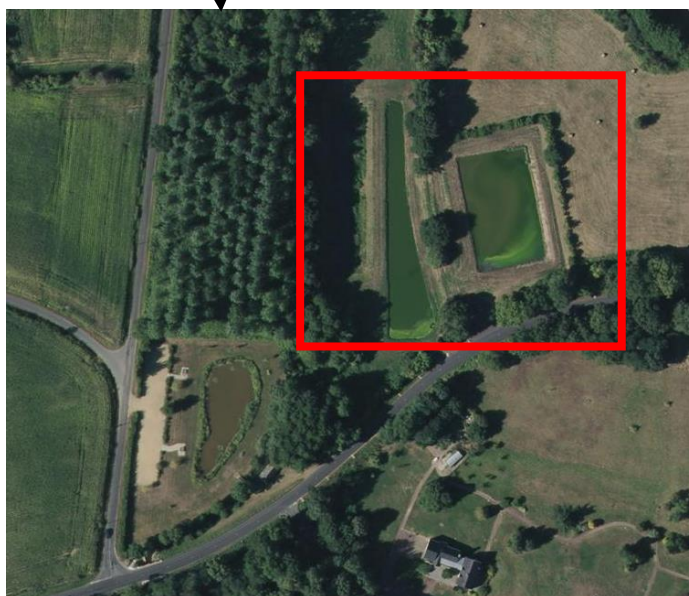
Figure 5: Station de traitement des eaux usées
