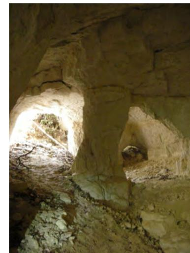
Photo 3: Ind. 020, pilier fracturé
