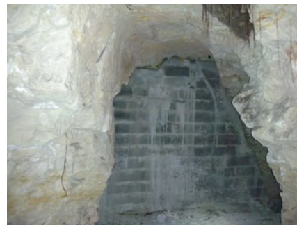
Photo 5: Ind. 005, accès muré à l'extension sous la RD 82
