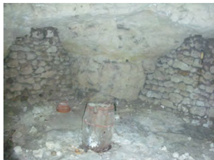
Photo 4: Ind. 005, probables extensions murées
