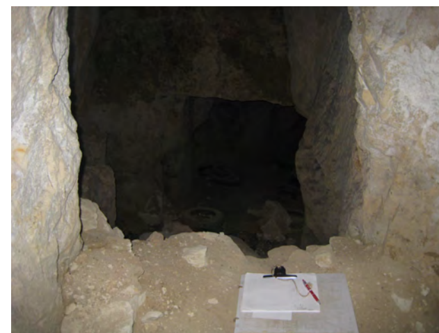
Photo 1: Ind. 016, galerie en demi niveau dans la carrière
