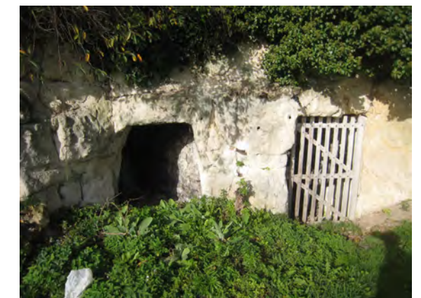
Photo 1: Entrées de cave (Ind. 017 et 018)
