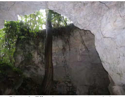
Photo 3: Effondrement, secteur de La Périchère
