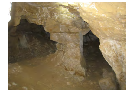
Photo 9: Pilier fracturé de la cavité se prolongeant rue des Caves (Ind. 116)
