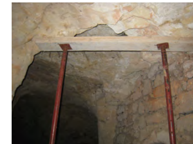
Photo 8: Cavité confortée par un étalement sous la rue des Caves (Ind. 116)
