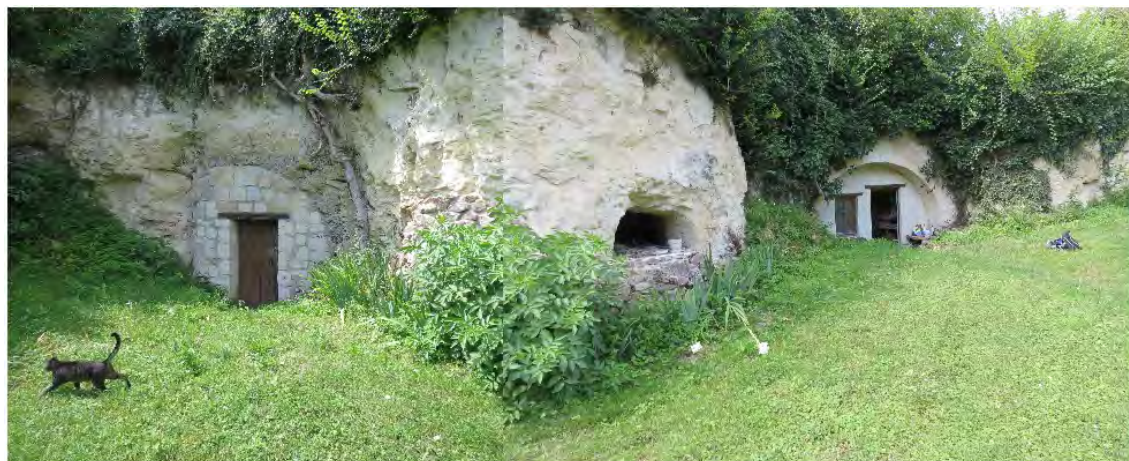
Photo 1: Ensemble de caves dépendances en carrière, au lieu-dit La Giraudière (Ind. 013, 017, 018, 019)
