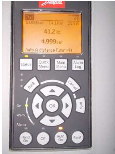
Electronique de variation de vitesse pompe immergée
