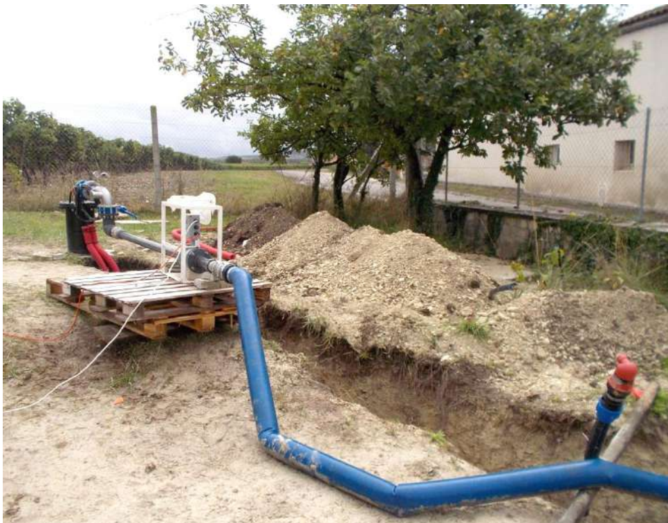
Ligne de mesure puits producteur
