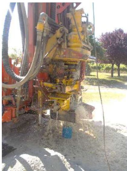
Photo 2 : nettoyage air lift du puits (juillet 2018)
