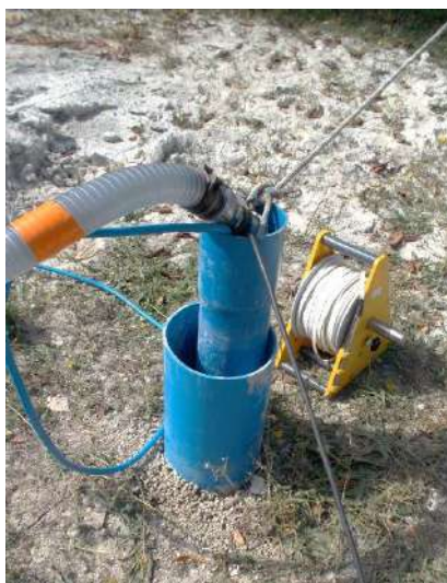
Photo 4 : équipement du forage pour les essais de pompage
