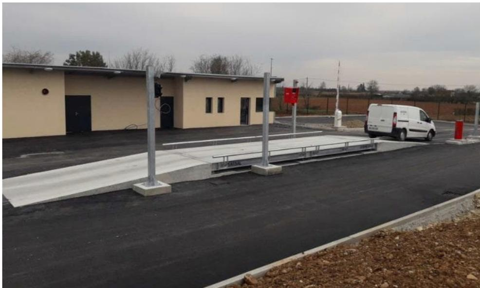
*Figure 24: Exemple de pont bascule hors-sol*
