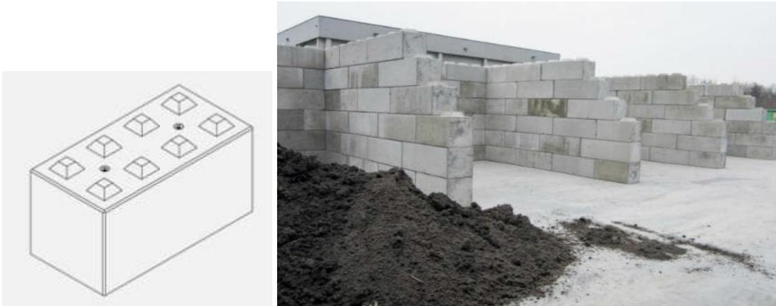
Figure 19: Illustrations de murs en blocs amovibles
