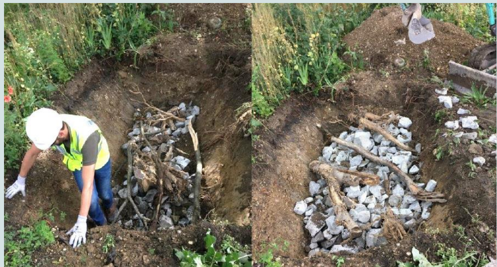
Figure 6 - Exemple de remplissage d'un hibernaculum (Egis)
