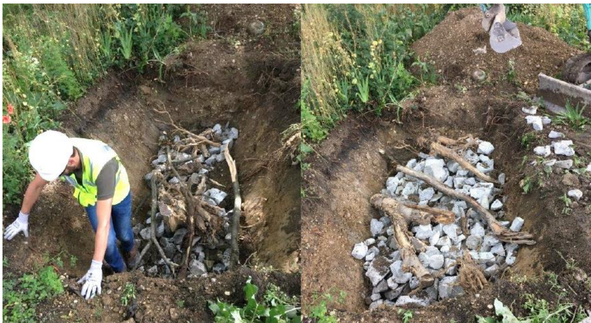
Figure 4 - Exemple de remplissage d'un hibernaculum (Egis)
