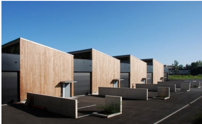
Exemple de bâtiments locatifs destinés aux artisans (Avignon)
