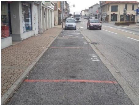
Stationnement axe RN7 dans la traversée de Livron-sur-Drôme
