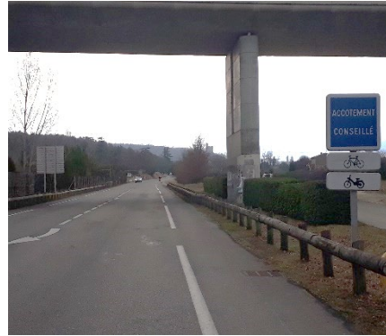
Accotements aménagés en faveur de la pratique cyclable
