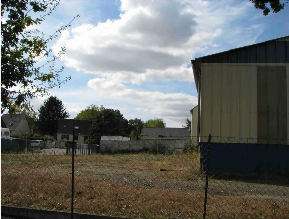
Photo 8 – secteur Cœur de bourg – Aperçu sur une friche dans la zone artisanale (L. Brunet)
