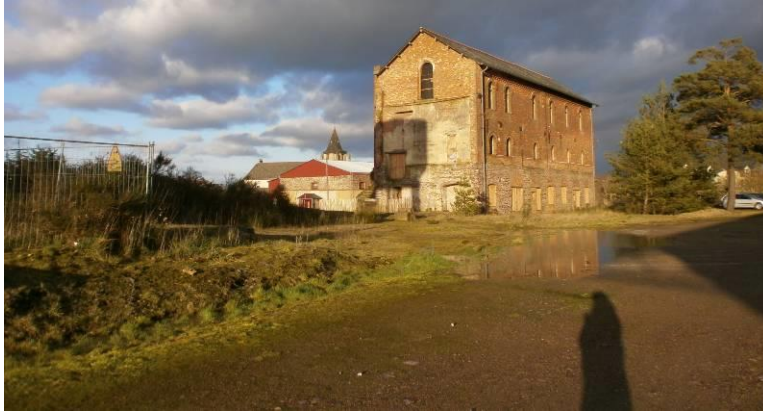
Photo 14 – secteur Ouest – vue Ouest – Est – anciens bureaux liés à la mine
