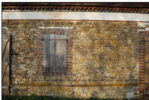
↑ Mise en œuvre du silex et du grison au Tuyau Blanc
