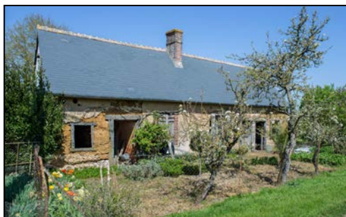
↑ Vue générale depuis le sud
