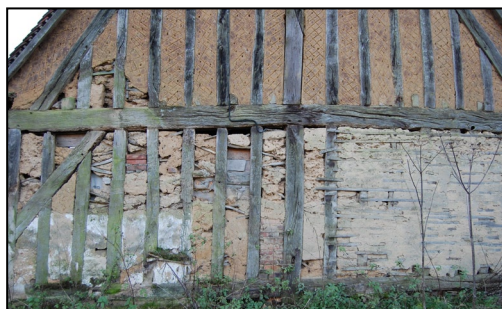
↑ Mise en œuvre du pan de bois aux Charmois
