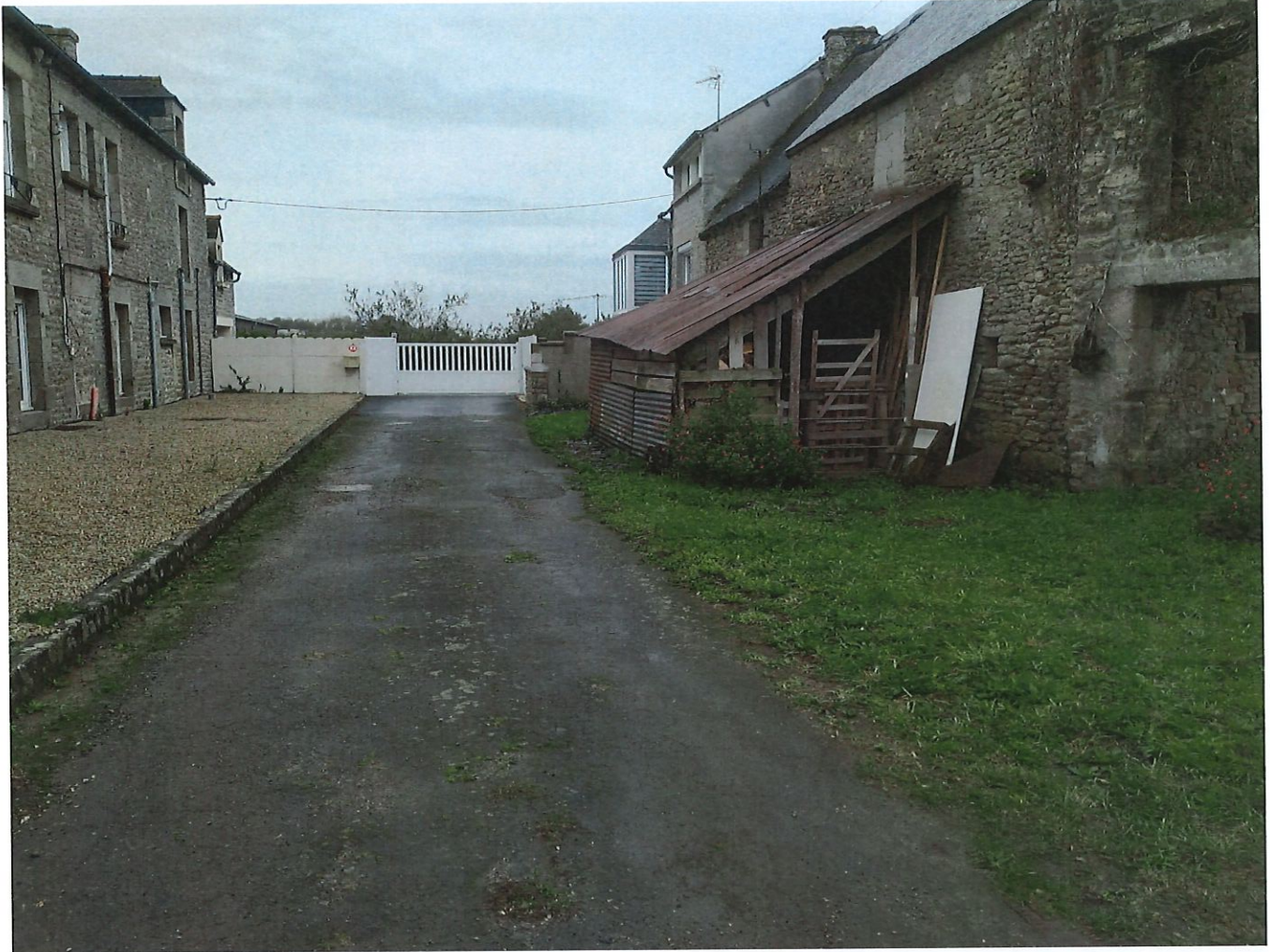
Accès au bâtiment par parcelle 792 (droit de passage) , le portail blanc est le début de la parcelle 263
