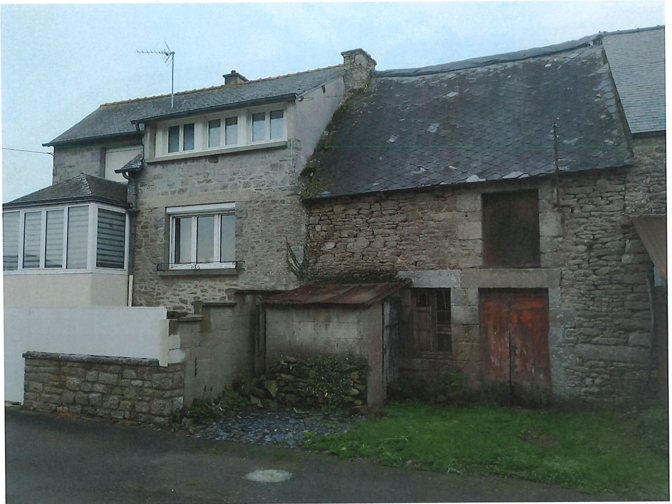
Le bâtiment avec présence d'un reste de raccord électrique sur la droite, vue gauche sur la mitoyenneté avec la maison du propriétaire des parcelles 263, 587, 262, 588
