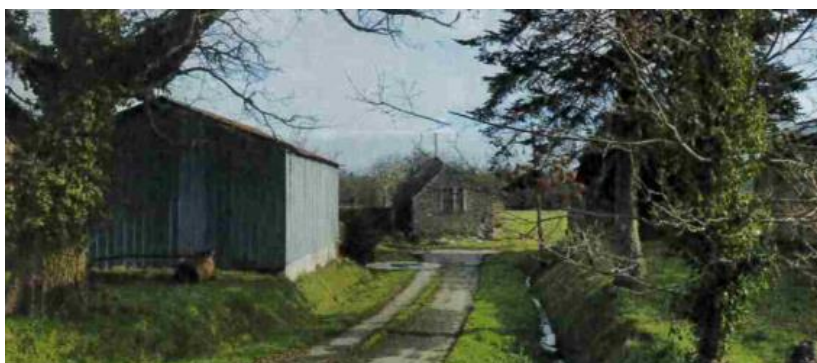
Le Geai, 284 Route de la Ville Neuve (dépendance, ancien garage)
