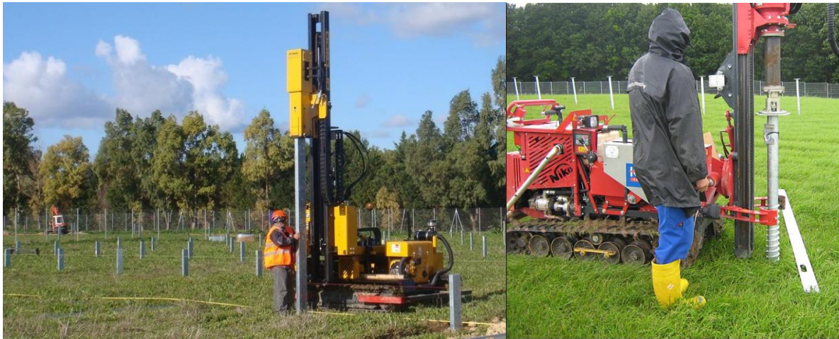
Sonnette de battage hydraulique(gauche) et machine hydraulique de vissage (droite)
