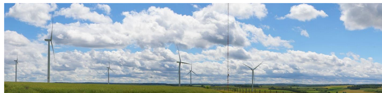
Figure 11 : Le parc éolien des Useroles et son mât de mesure au sud de la commune de Poiseul-la-Ville-et-Laperrière
