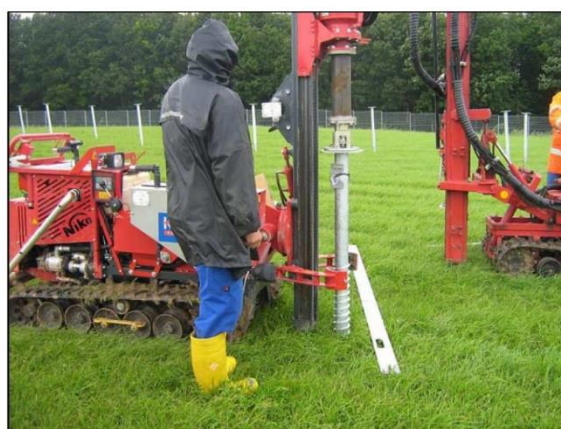
Machine hydraulique de vissage
