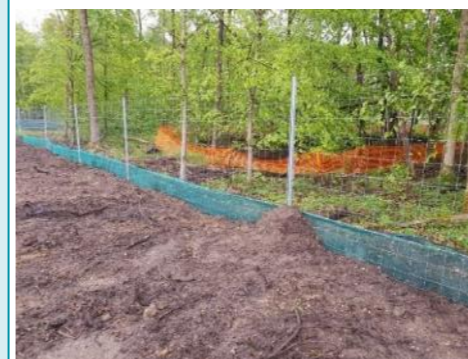
Exemple de dispositif anti-intrusion et semi-perméable © Biotope
