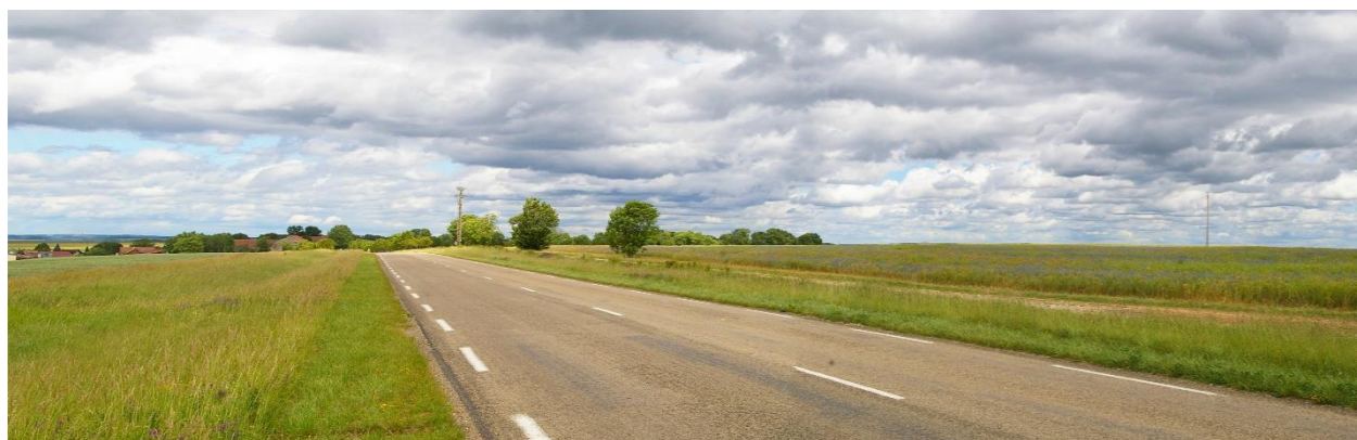
Figure 43 : Portion de la D971 offrant des vues sur l'aire d'étude immédiate, ici à droite de la route
