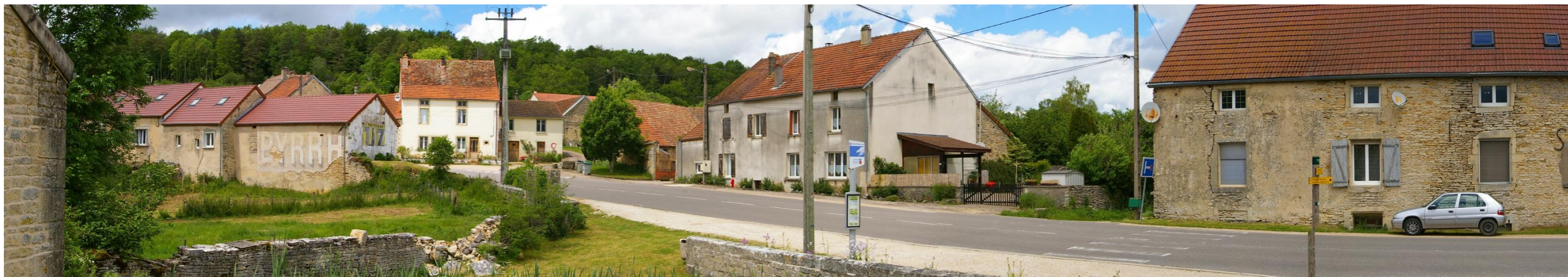
Figure 35 : Trame bâtie discontinue, à Courceaux
