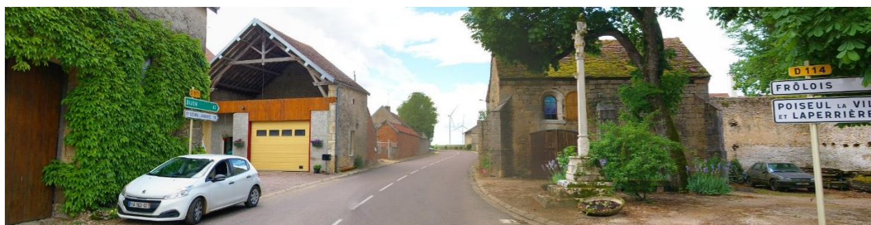
Figure 44 : Laperrière, situé au croisement entre la D971 et la D114a
