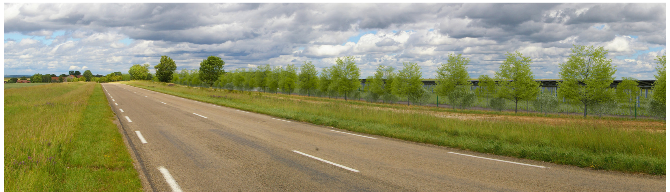
Vue 1: Vue du poste de transformation 3 depuis la départementale 971 au Sud du site (avec la haie).
