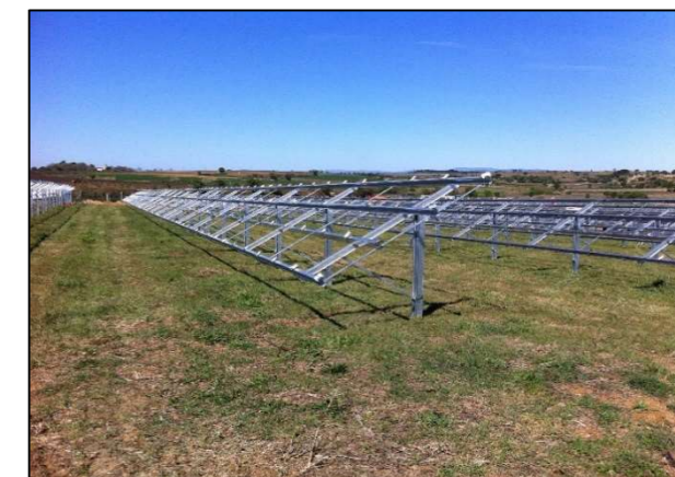
Exemple de vue des structures avec pieux battus montrant le maintien du sol et de la végétation herbacée
