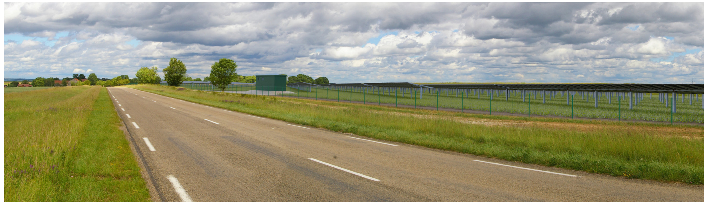
Vue 1: Vue du poste de transformation 3 depuis la départementale 971 au Sud du site (sans la haie).
