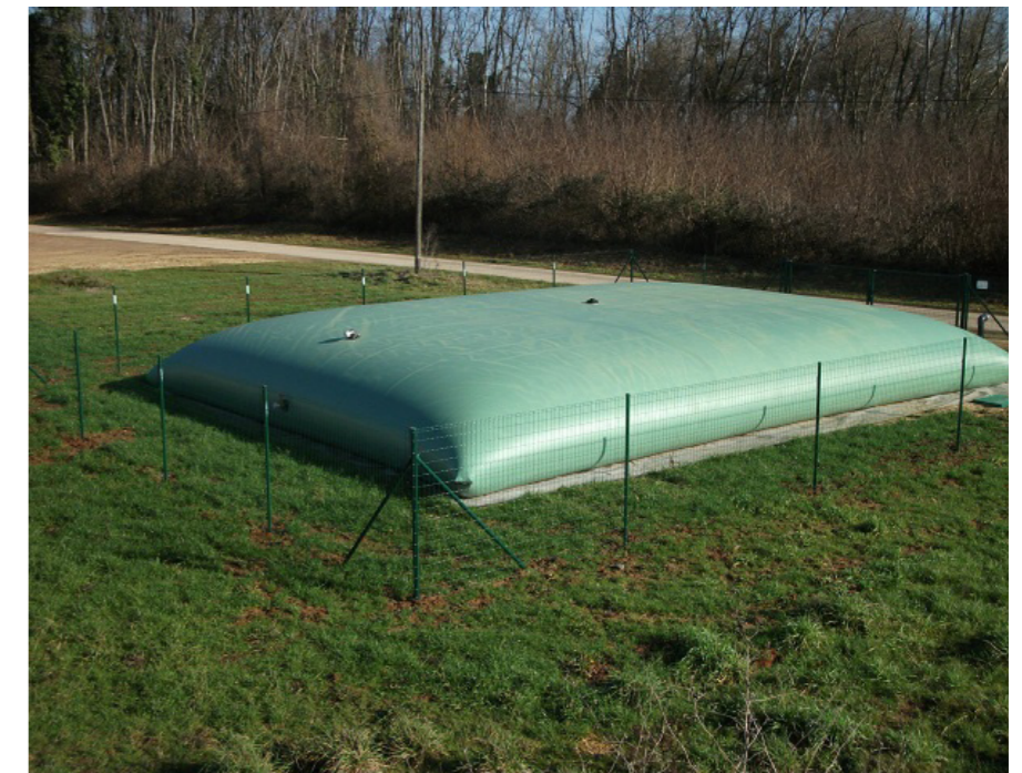
Citernes à eau: - 3x 30 m 3 pour les services incendie.
