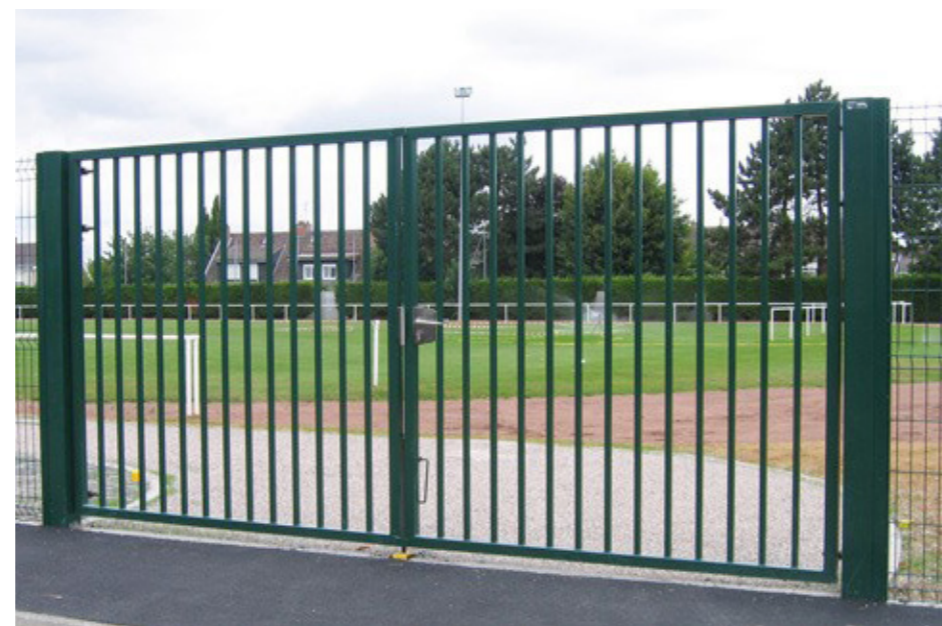
Portail d'accès au site
