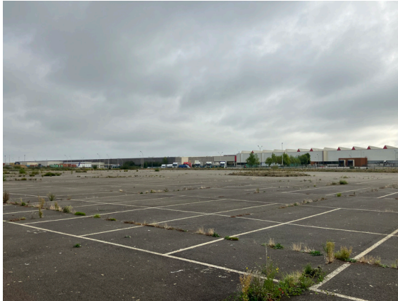
Un site aujourd'hui largement imperméabilisé
