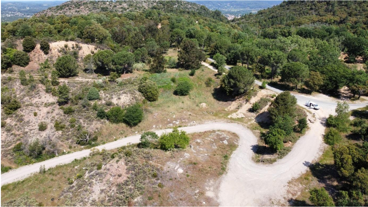
Photo du site par drone
