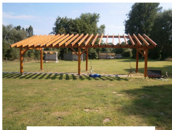
Exemple de pas de tir couvert (en cours de construction)
