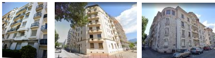
1 bis rue Jules Ferry, construit en 1933 par l'architecte Georges Serbonnet. / 17-19 rue Jules Ferry, construit en 1932 par les architectes Chapperon et Reverdy, / 17 avenue Jean Jaurès, construit en 1939 par le cabinet d'architecte Dénarié et Davignon.
