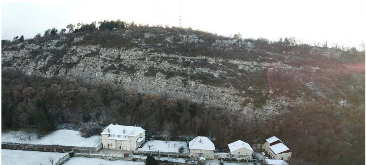
Vue drone du château (Géolithe 2019)
