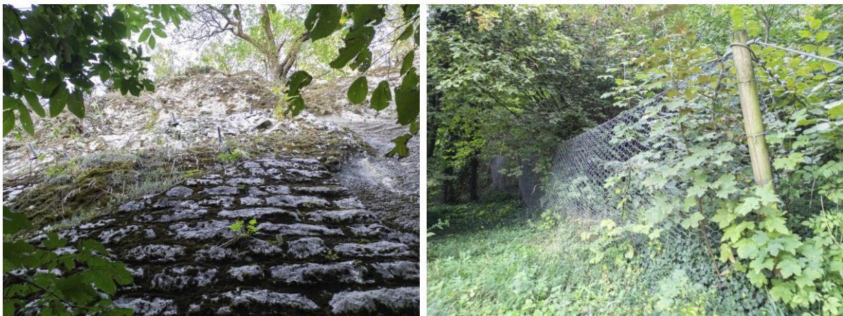
Vue des protections : confortements actifs et écran grillagé
