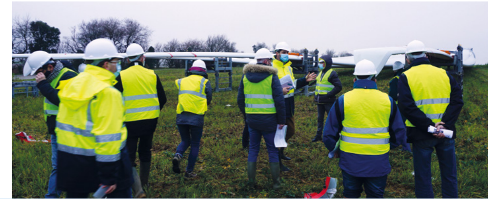
Visite des élus sur le chantier du parc éolien d'Auzay (85)
