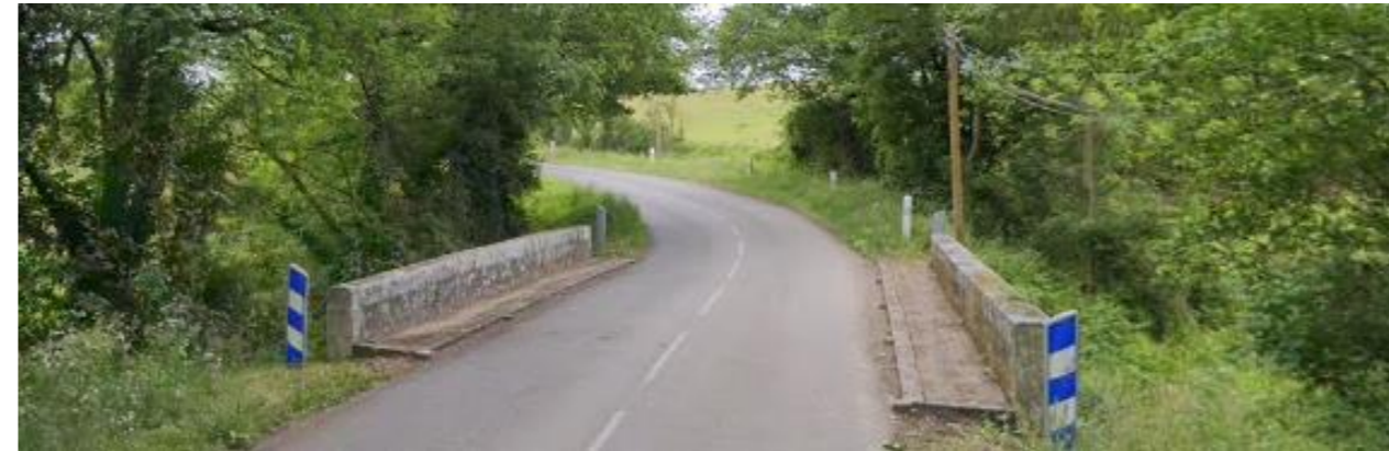
Figure 99. Petit pont franchissant le ruisseau du Tourteron au niveau de la D88 © Google 2022 (mai 2021)
