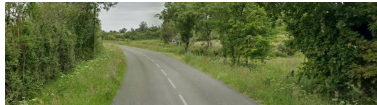
Figure 100. Affluent du Tourteron au niveau de la D88 (avec buse permettant le franchissement du ruisseau) © Google 2022 (mai 2021)
