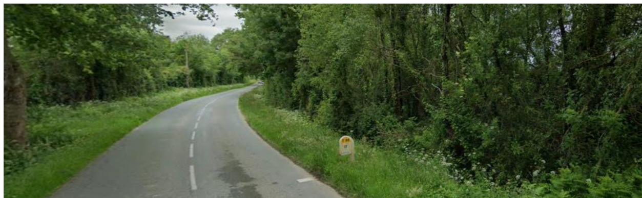
Figure 98. Affluent du Tourteron au niveau de la D88 (avec buse permettant le franchissement du ruisseau) © Google 2022 (mai 2021)
