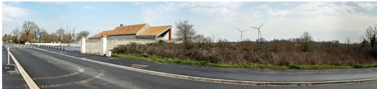
Vue depuis la D60 - au niveau du cimetière de Château-Guibert (PM42)
