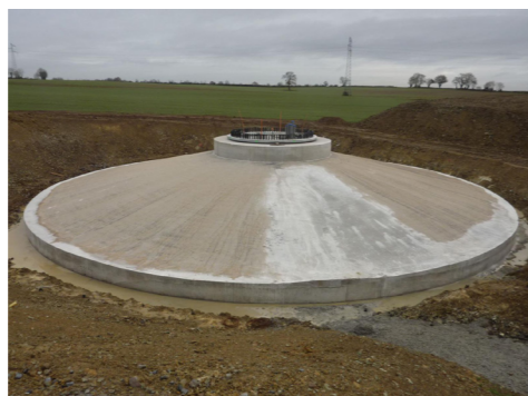
PHOTOGRAPHIE D'UNE FONDATION D'ÉOLIENNE
