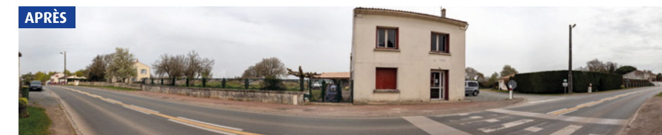
Traversée du centre bourg de Balanzac, le long de la RD728
