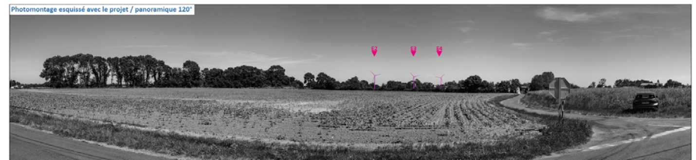
Illustration 200 : Extrait de la simulation 51, esquisse du projet à 120° (depuis la RD122 au NO de Ste-Gemme)
