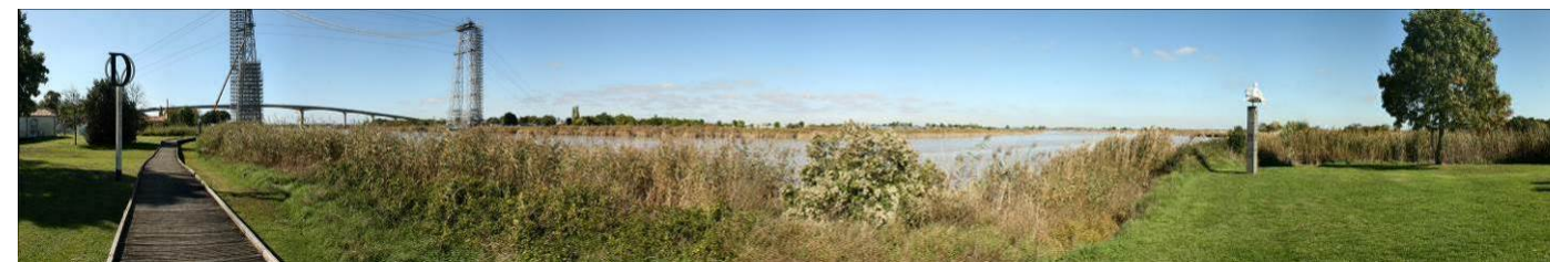
Illustration 45 : pont transbordeur entre Echillais et Rochefort
