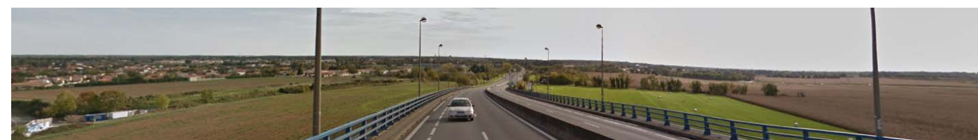
Illustration 29 : Vue depuis la D733 au niveau du pont au-dessus de la Charente (source : Google maps)
