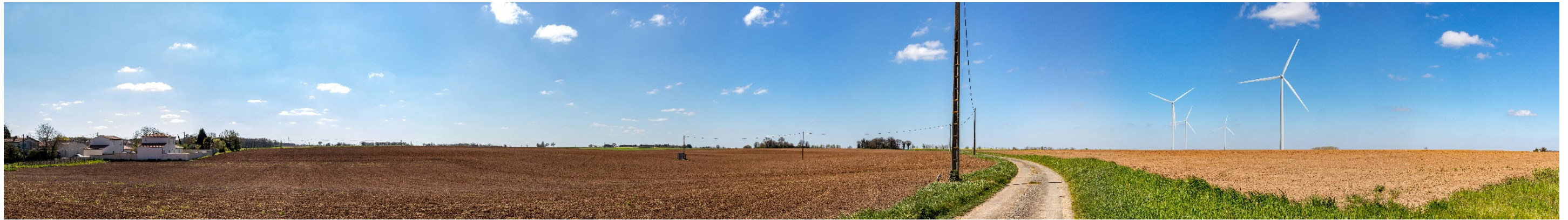
Hauteur totale de 200 m
