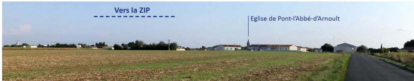
Illustration 88 : covisibilité potentielle depuis la RD215 entre l'église et le site du projet
