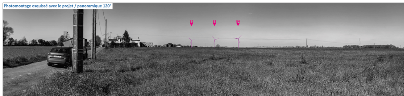
Illustration 191 : Extrait de la simulation 61, esquisse du projet à 120° (depuis l'est de Nanclas à l'intersection entre la RD728 et la RD142)
