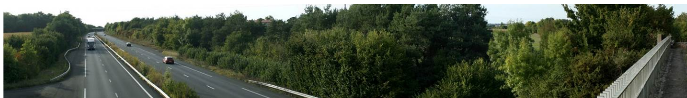
Illustration 23 : Vue depuis la route A837 au niveau de Bords
