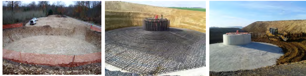
Figure 8 : Réalisation des fondations ; phase d'excavation ; phase de ferrailage ; phase de remblaiement (source : Q ENERGY France)
