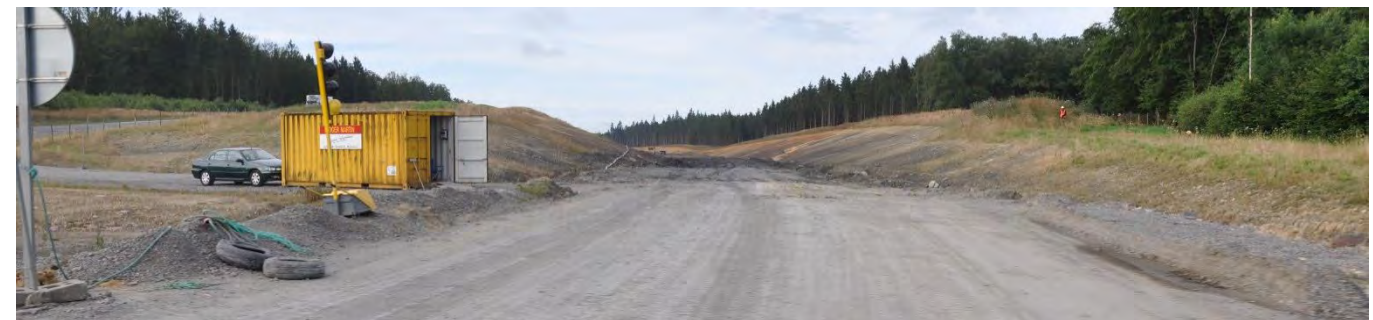
Travaux de prolongement de l'A34, avec création d'une trouée dans le boisement de conifères, au Sud de Rocroi
