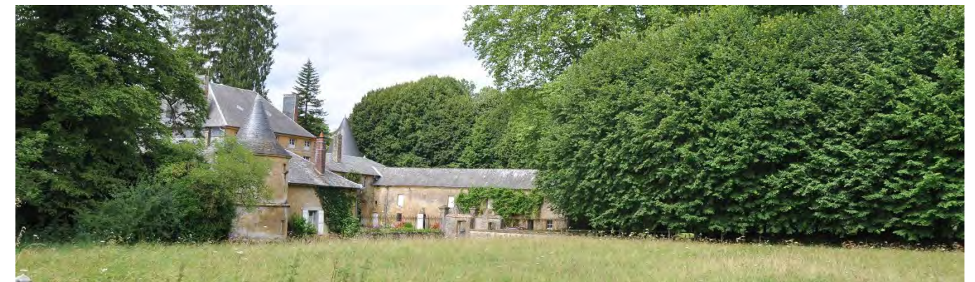
Château de Gruyères (27), une maison forte s'insérant dans un écrin boisé limitant sa visibilité
