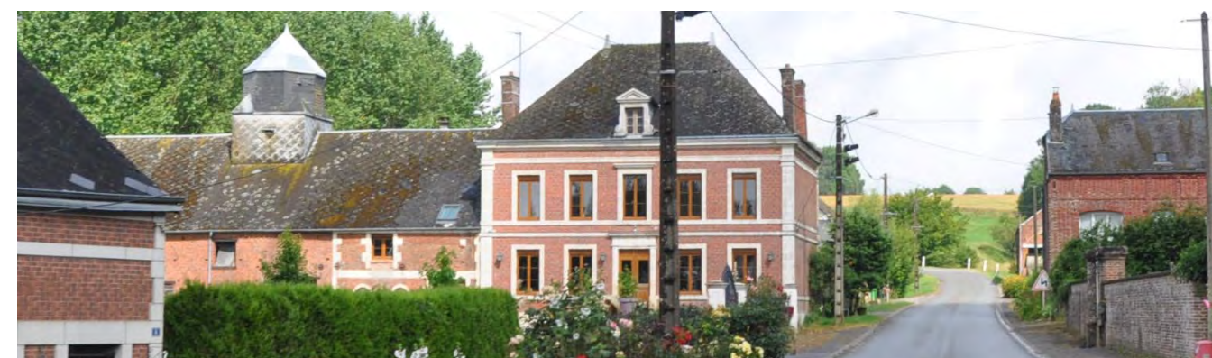
Architecture mêlant la brique au calcaire (cadres des fenêtres) et l'ardoise pour la toiture
