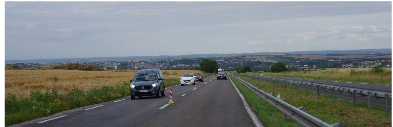
Zone de basculement vers la vallée de l'Aisne, au Sud de Rethel, offrant aux automobilistes une vue en belvédère vers le Nord (RN51)
