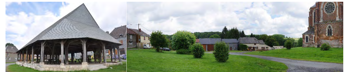
La halle de Saint-Jean-aux-Bois (10), un édifice compact bénéficiant d'une vue orientée vers l'extérieur du bourg (à droite)
