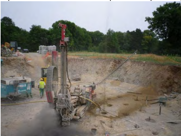
Atelier de forage, armement et coulage de mortier
