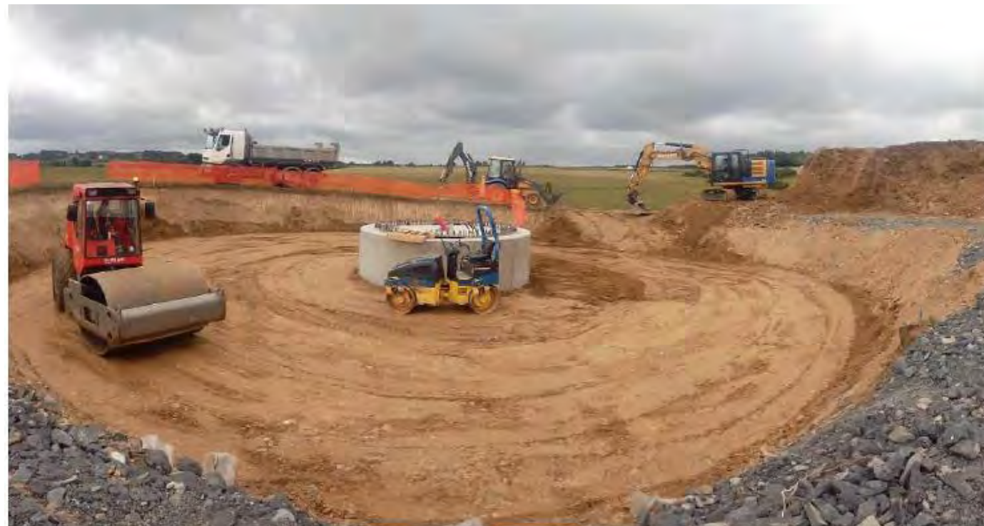
Figure 36 : Fondation d'une éolienne à l'issue du compactage (Source : RES)
