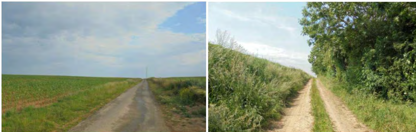
Figure 31 : Exemples de voirie existante à élargir, avec différentes bandes roulantes (Source : QENERGY – Côte des Vauzelles)
