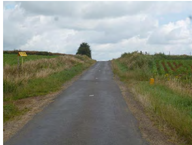
Figure 56 : Balisage de la canalisation de transport de gaz naturel au niveau de la RD56 (Crédit photo : NCA, juillet 2016)
