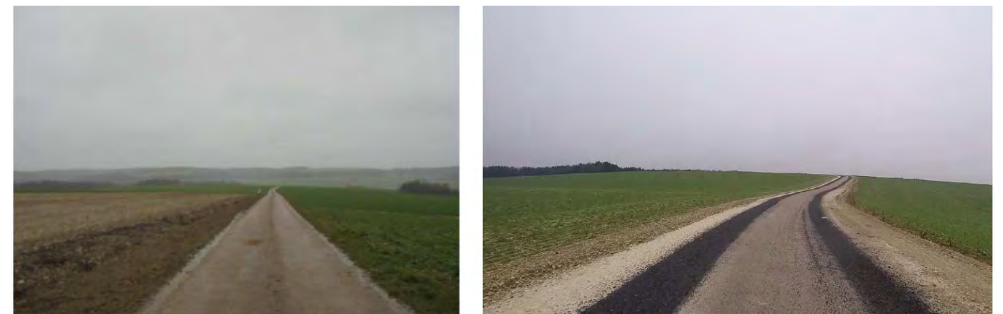
Figure 29 : Exemple de voie existante avant (gauche) et après (droite) aménagement (Source : RES)
