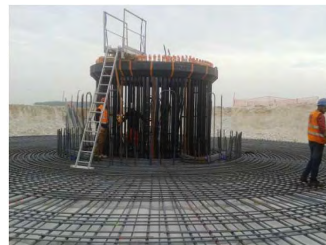
Pose du système d'ancrage
