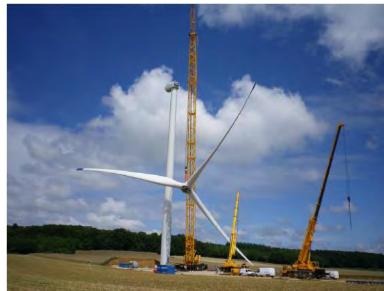
Figure 37 : Photographies des opérations de montage d'une éolienne (Source : RES)
