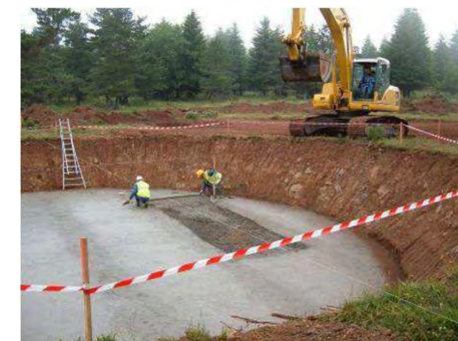
Béton de propreté
