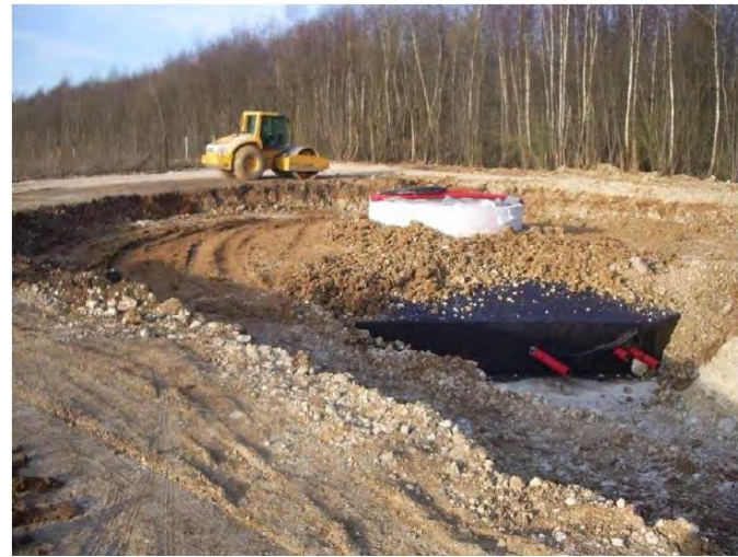
Remblaiement et compactage
