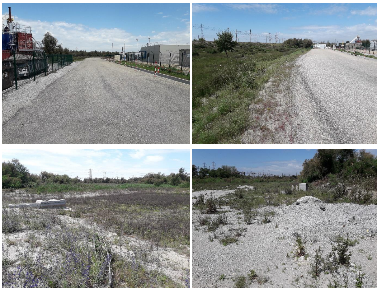
Zone des aménagements de Jupiter 1000. De gauche à droite et de haut en bas : voie de circulation au nord de Jupiter 1000, au niveau du démonstrateur Carbolyse ; voie de circulation à l'ouest de Jupiter ; bassin de rétention entre Jupiter et la darse ; zone terrassée mais non aménagée au nord de Jupiter.
