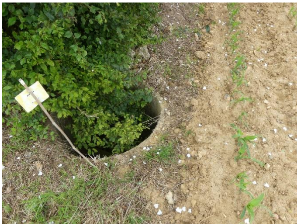
« puits » du collecteur de drainage angle parc. ZK 38 et 41 la Bochetière
