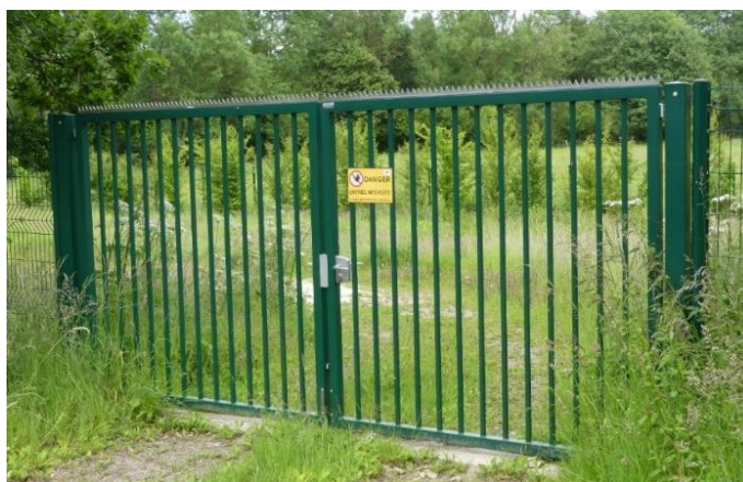
Figure 8 : entrée de la station de la Clouterie
