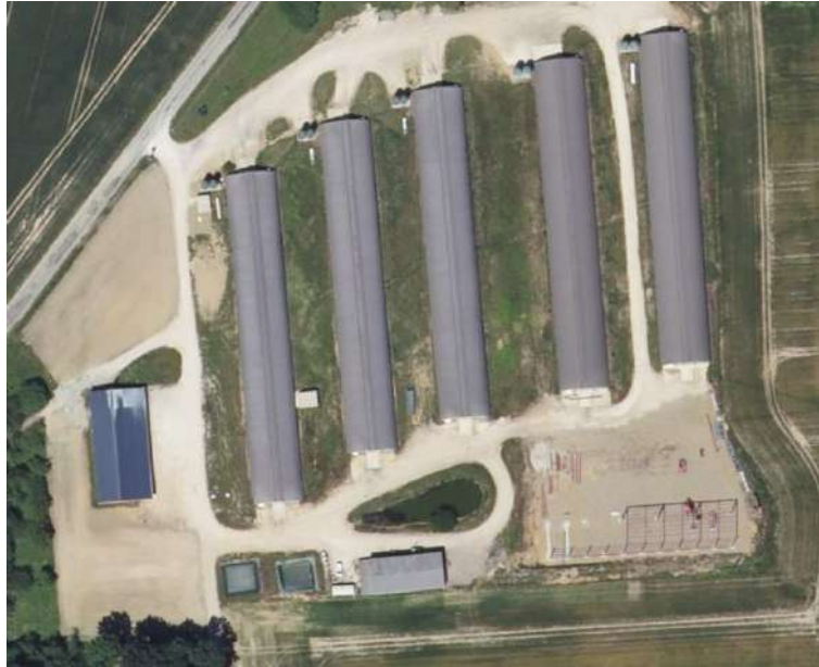
Figure 38 : Bâtiments d'élevages avicoles les Ormes (photographie Géoportail 2020)
