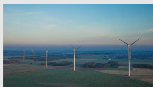
Parc de BEL AIR Département : Charente-Maritime (17) Puissance électrique : 19,8MW 9 éoliennes Mise en service : 2020
