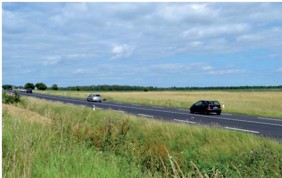
D83 qui traverse le ban communal d'Éguenigue
