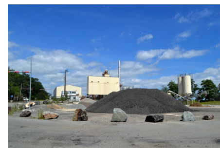
Site industriel et stockage des enrobés
