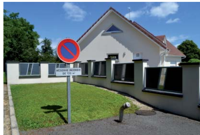
Réserve incendie localisée dans l'impasse du Sentier source : AUTB, 2018
