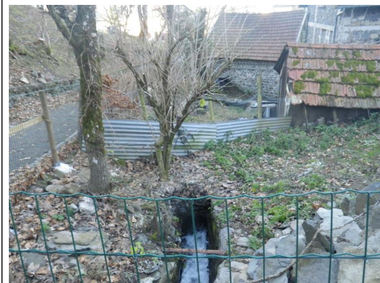
Busage de la dérivation sous des bâtiments
