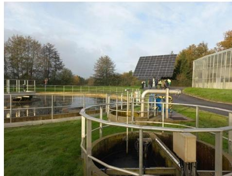
Trackers solaires – STEP de Lailé – production estimée à 82 MWh annuels – Source : OK Wind
