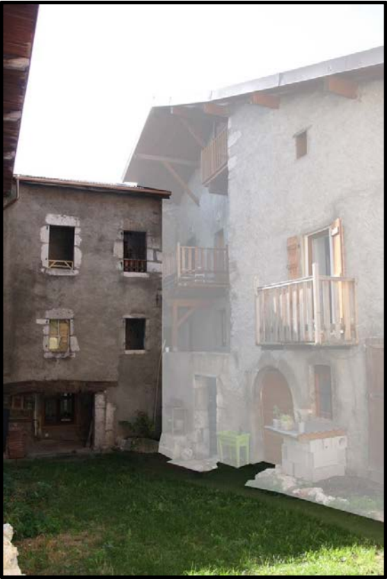
FAÇADE RUE DU BOURG
