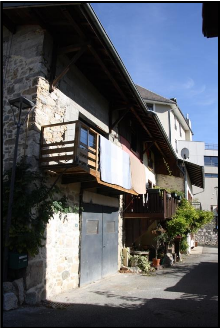
FAÇADE RUE DE L'ÉGLISE
