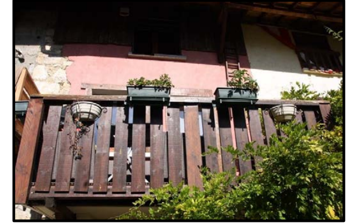
FAÇADE RUE DE L'ÉGLISE
