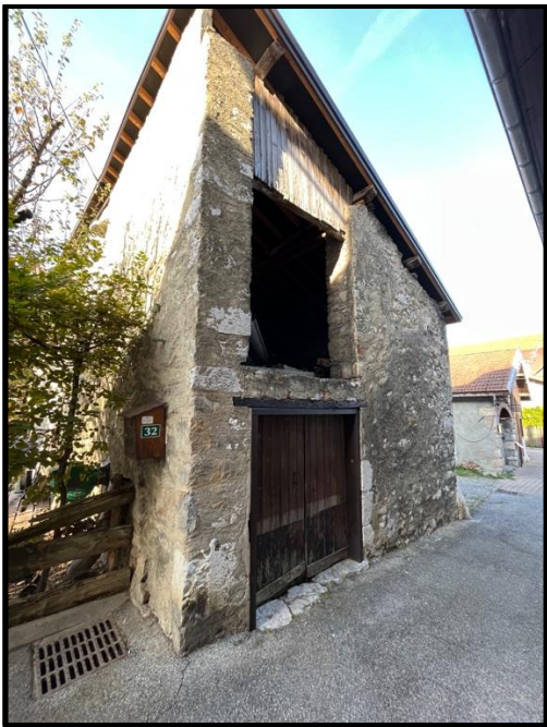
FAÇADE RUE DU BOURG
