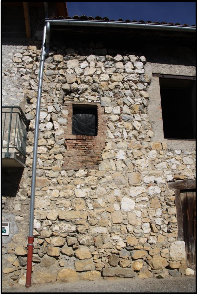
FAÇADE RUE DE L'ÉGLISE
