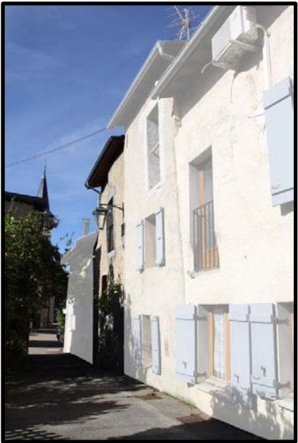
FAÇADE DONNANT SUR LA RUE DU BOURG
