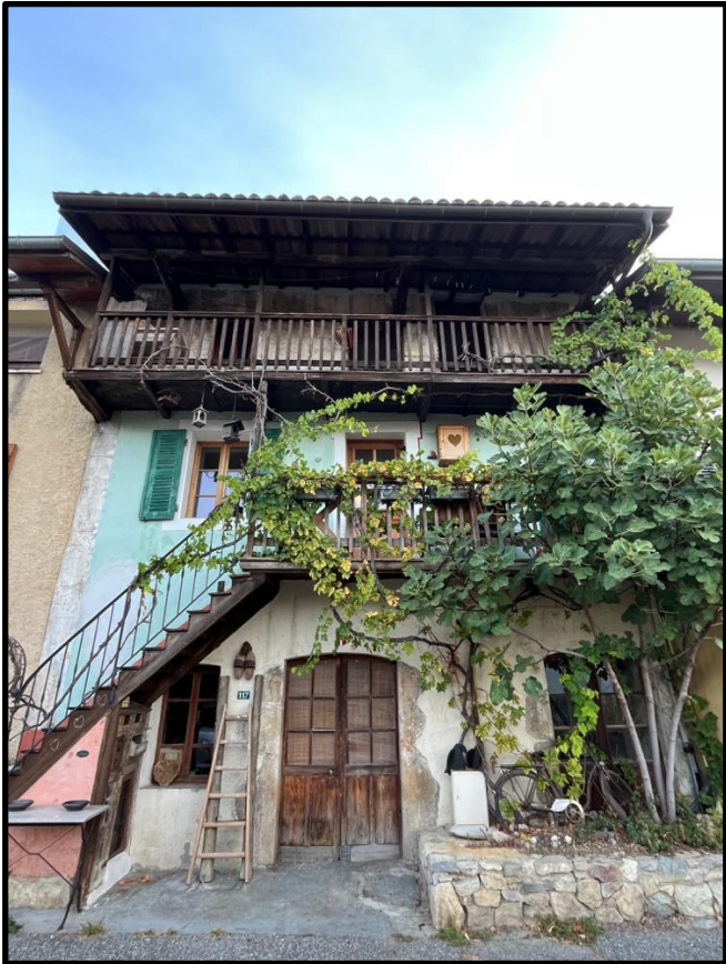
FAÇADE RUE DE L'ÉGLISE
