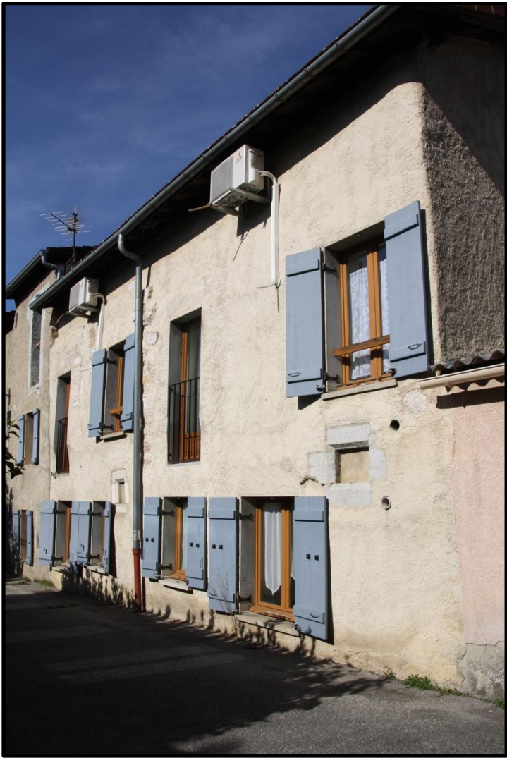
FAÇADE DONNANT SUR LA RUE DU BOURG
