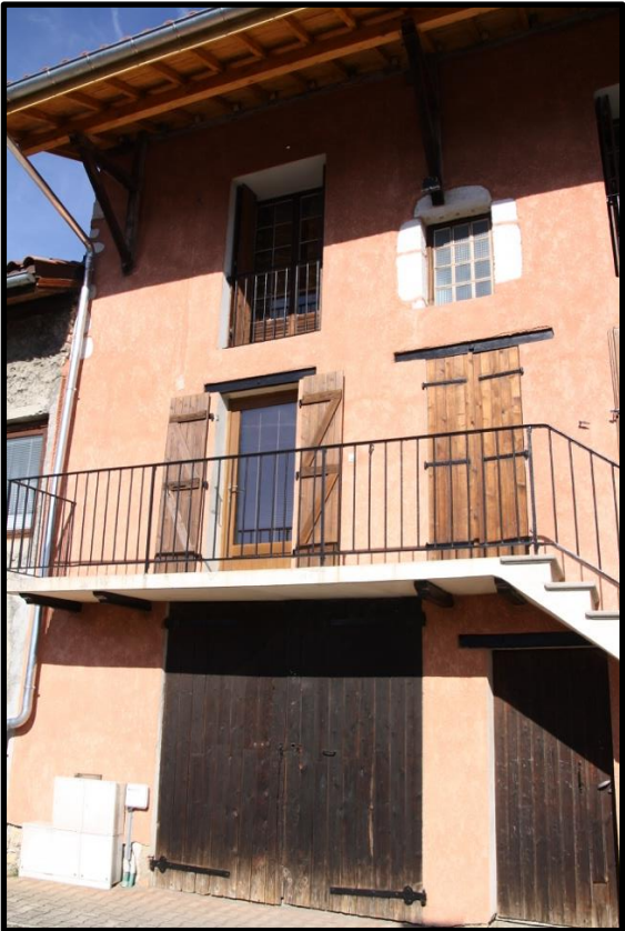
FAÇADE RUE DE L'ÉGLISE
