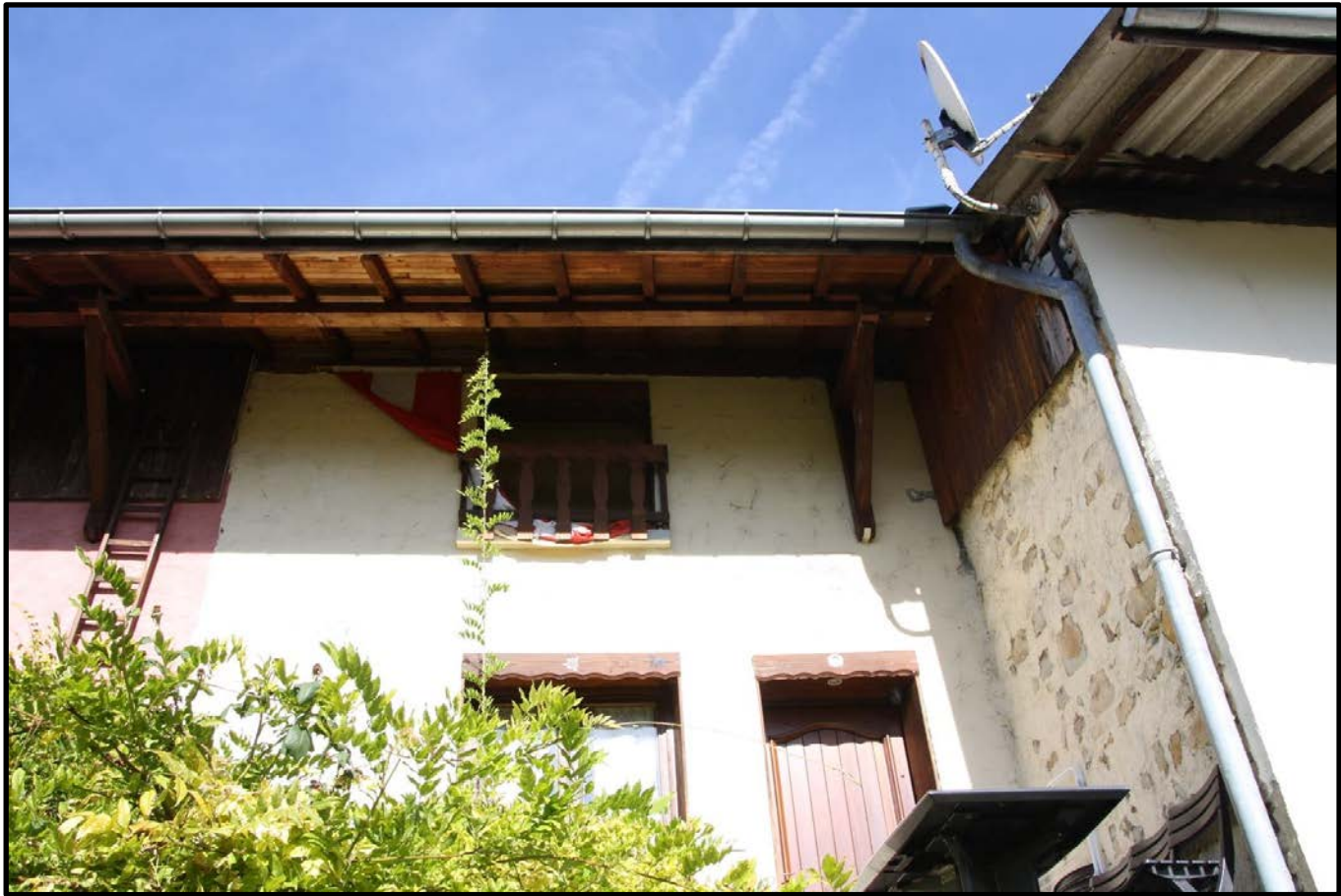
FAÇADE RUE DE L'ÉGLISE
