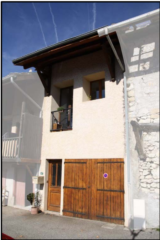
FAÇADE RUE DE L'ÉGLISE
