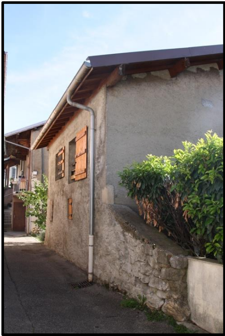
FAÇADE RUE DU BOURG
