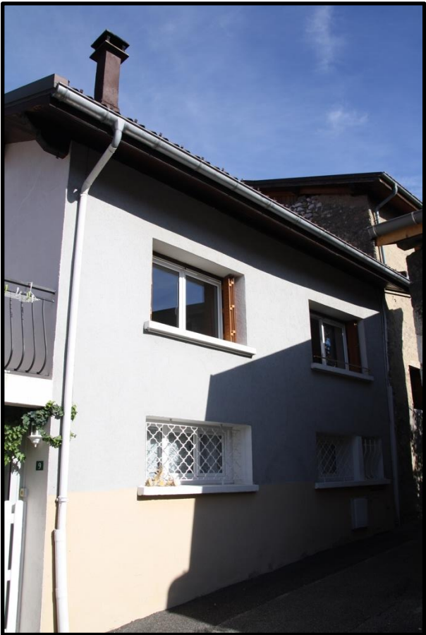
FAÇADE DONNANT SUR LA RUE DU BOURG
