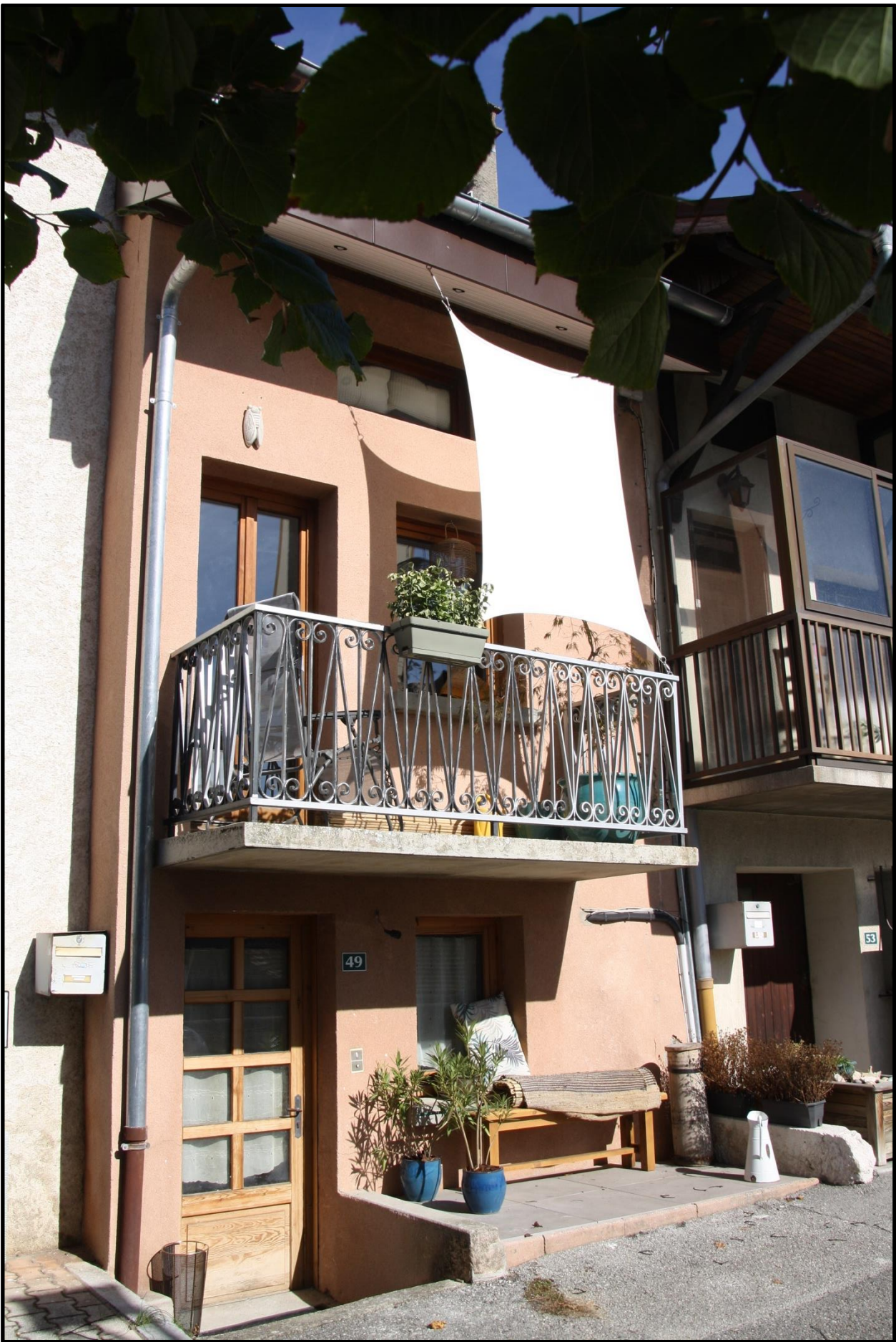
FAÇADE RUE DE L'ÉGLISE
