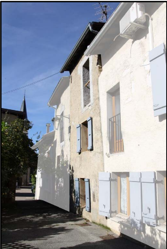
FAÇADE DONNANT SUR LA RUE DU BOURG
