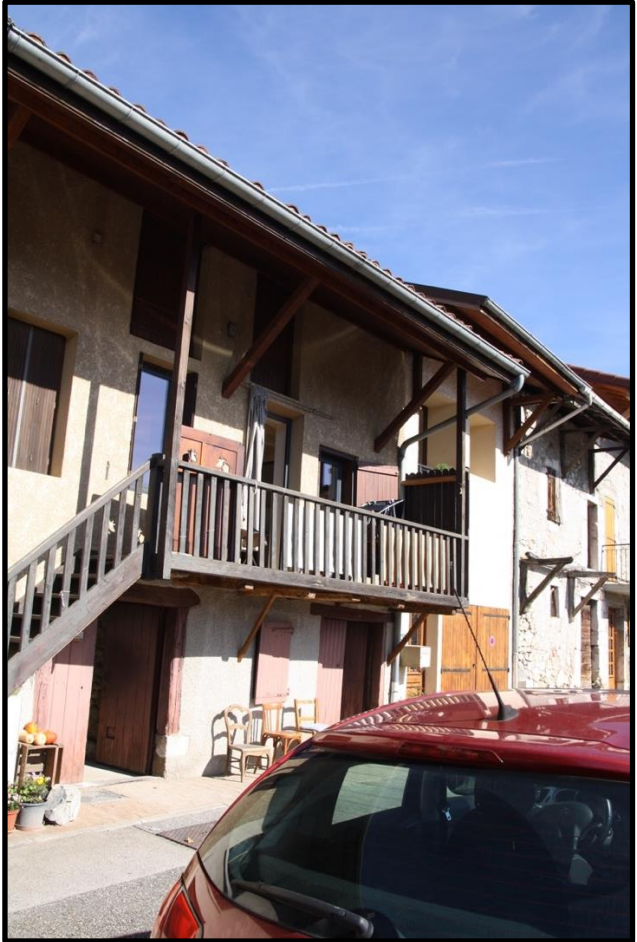
FAÇADE RUE DE L'ÉGLISE
