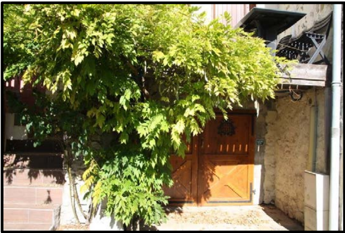
FAÇADE RUE DE L'ÉGLISE
