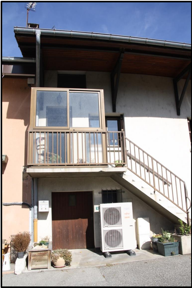
FAÇADE RUE DE L'ÉGLISE
