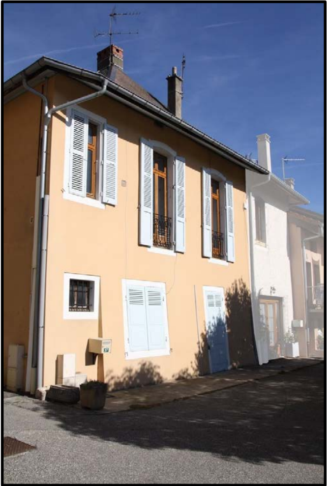
FAÇADE RUE DU BOURG
