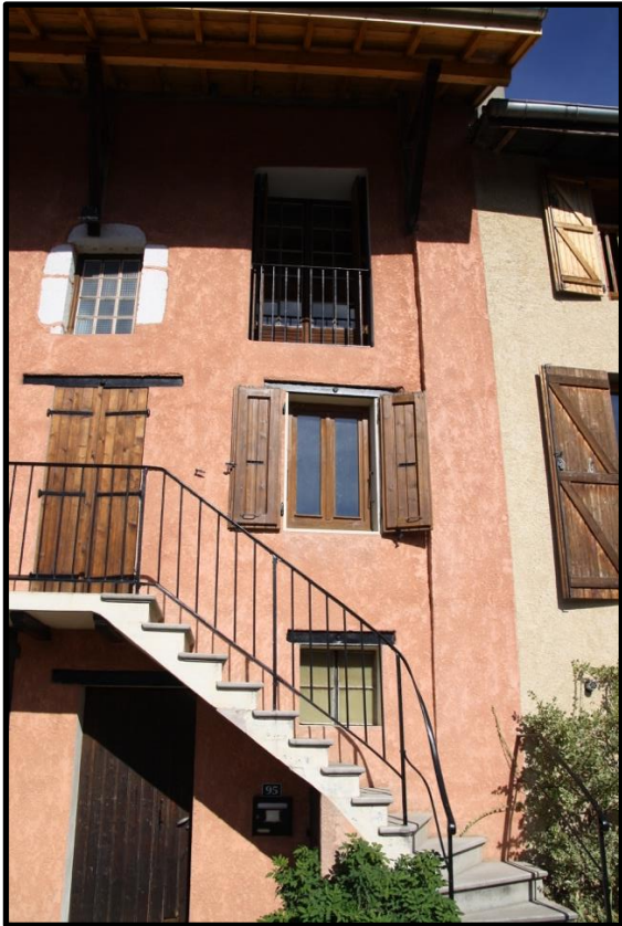
FAÇADE RUE DE L'ÉGLISE
