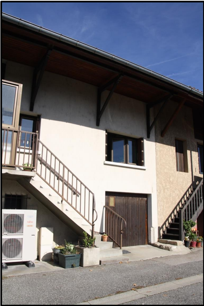
FAÇADE RUE DE L'ÉGLISE
