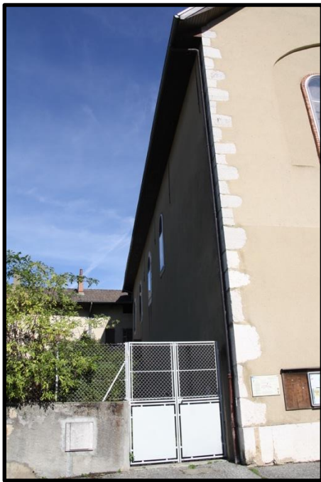
FAÇADE RUE DE L’ÉGLISE
