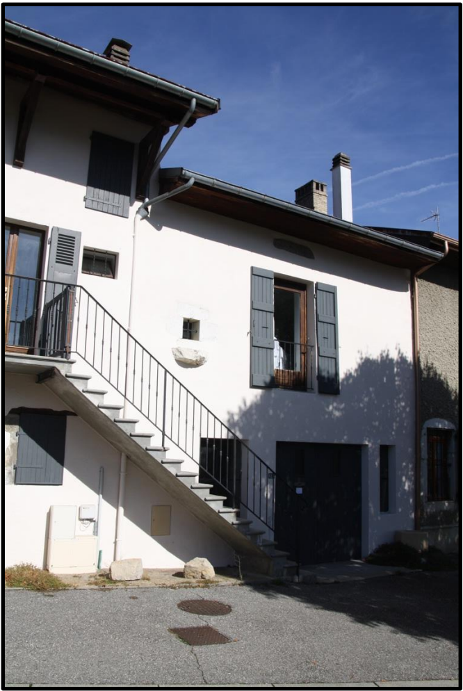
FAÇADE RUE DE L'ÉGLISE
