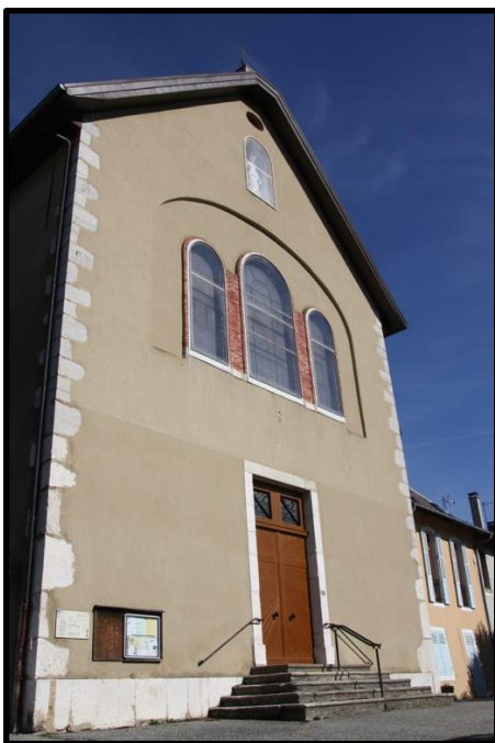
FAÇADE RUE DE L’ÉGLISE
