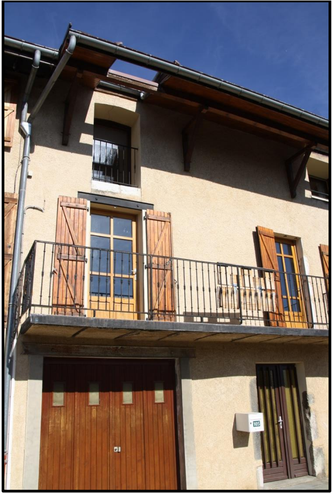
FAÇADE RUE DE L'ÉGLISE
