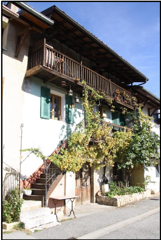
FAÇADE RUE DE L'ÉGLISE
