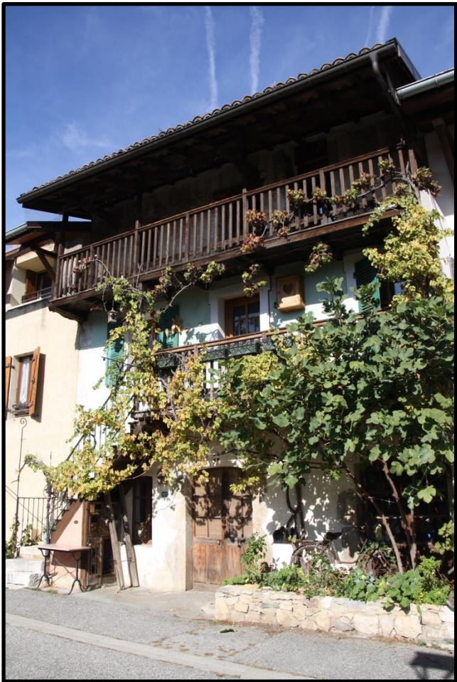
FAÇADE RUE DE L'ÉGLISE
