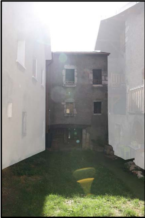
FAÇADE RUE DU BOURG
