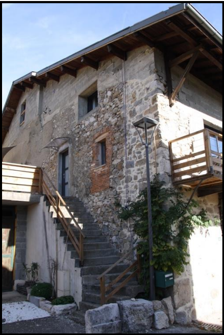
FAÇADE RUE DE L'ÉGLISE
