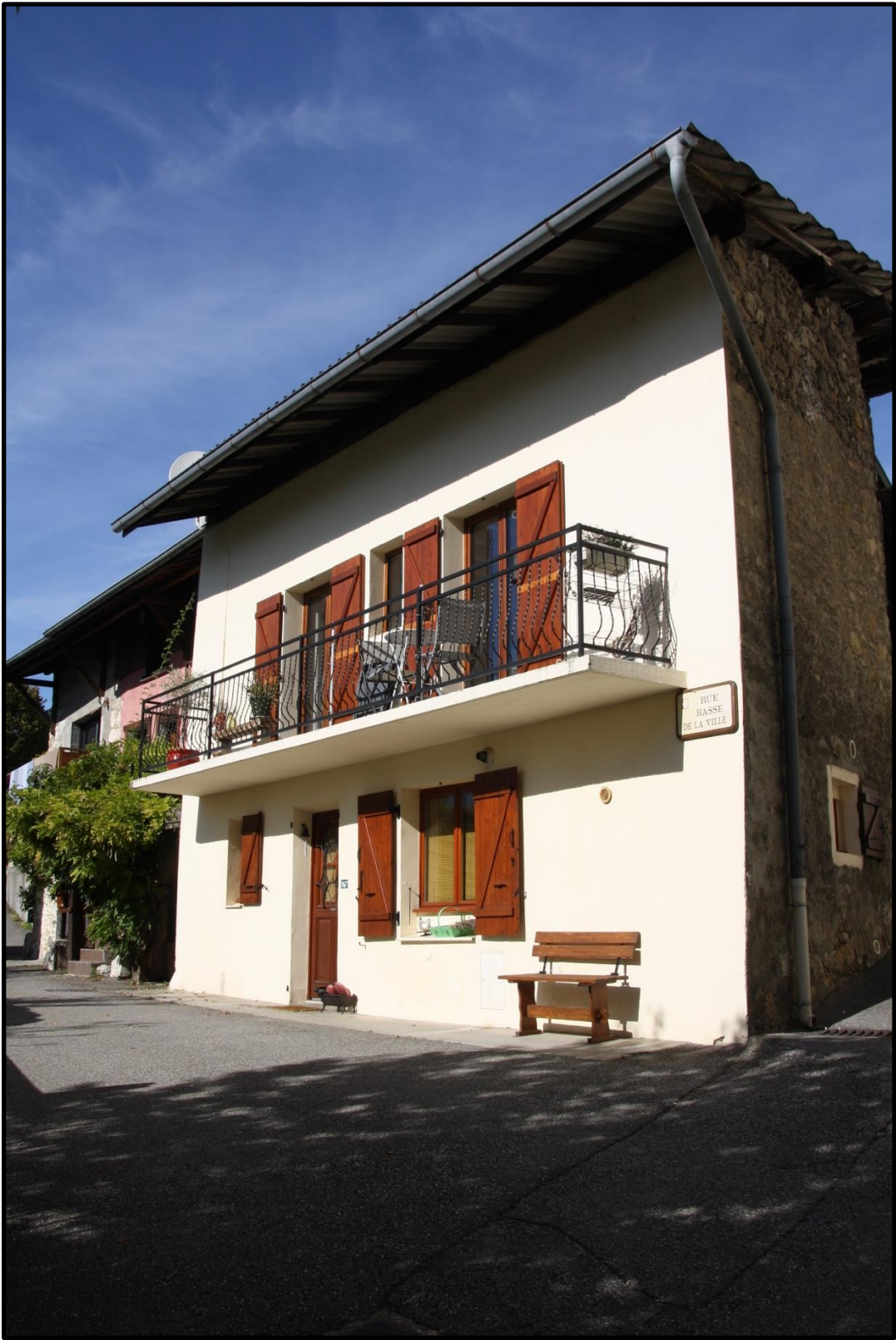
FAÇADE RUE DE L'ÉGLISE
