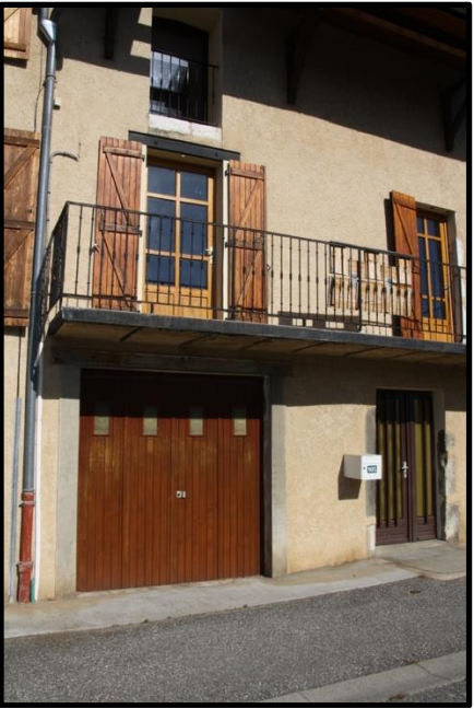
FAÇADE RUE DE L'ÉGLISE
