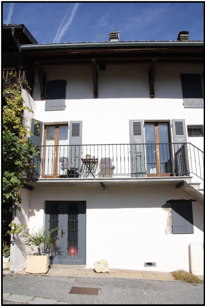
FAÇADE RUE DE L'ÉGLISE
