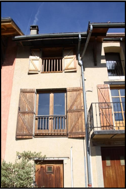
FAÇADE RUE DE L'ÉGLISE
