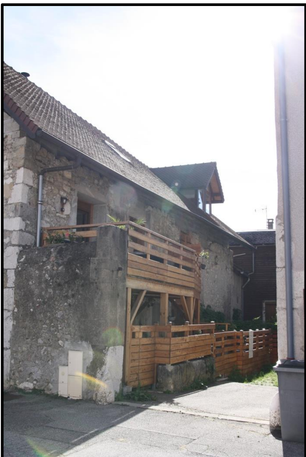
FAÇADE COUR INTERIEURE
