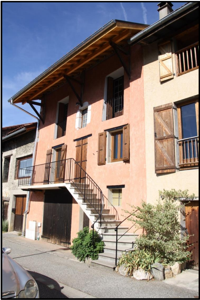
FAÇADE RUE DE L'ÉGLISE
