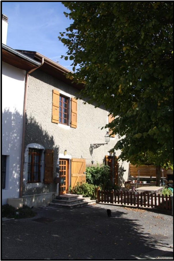
FAÇADE RUE DE L'ÉGLISE
