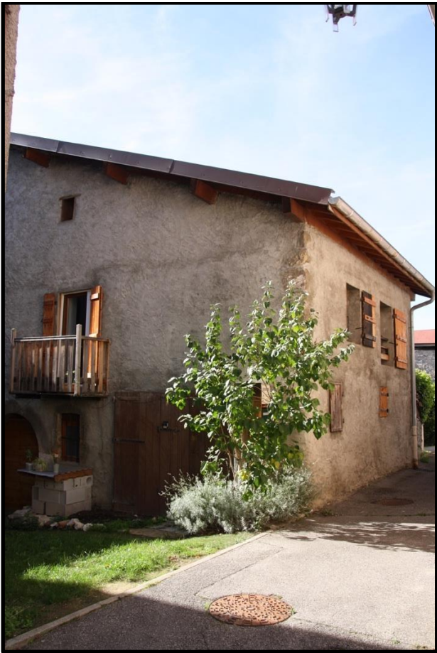
FAÇADES SUD-EST ET RUE DU BOURG
