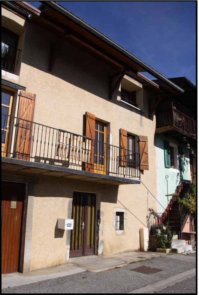
FAÇADE RUE DE L'ÉGLISE
