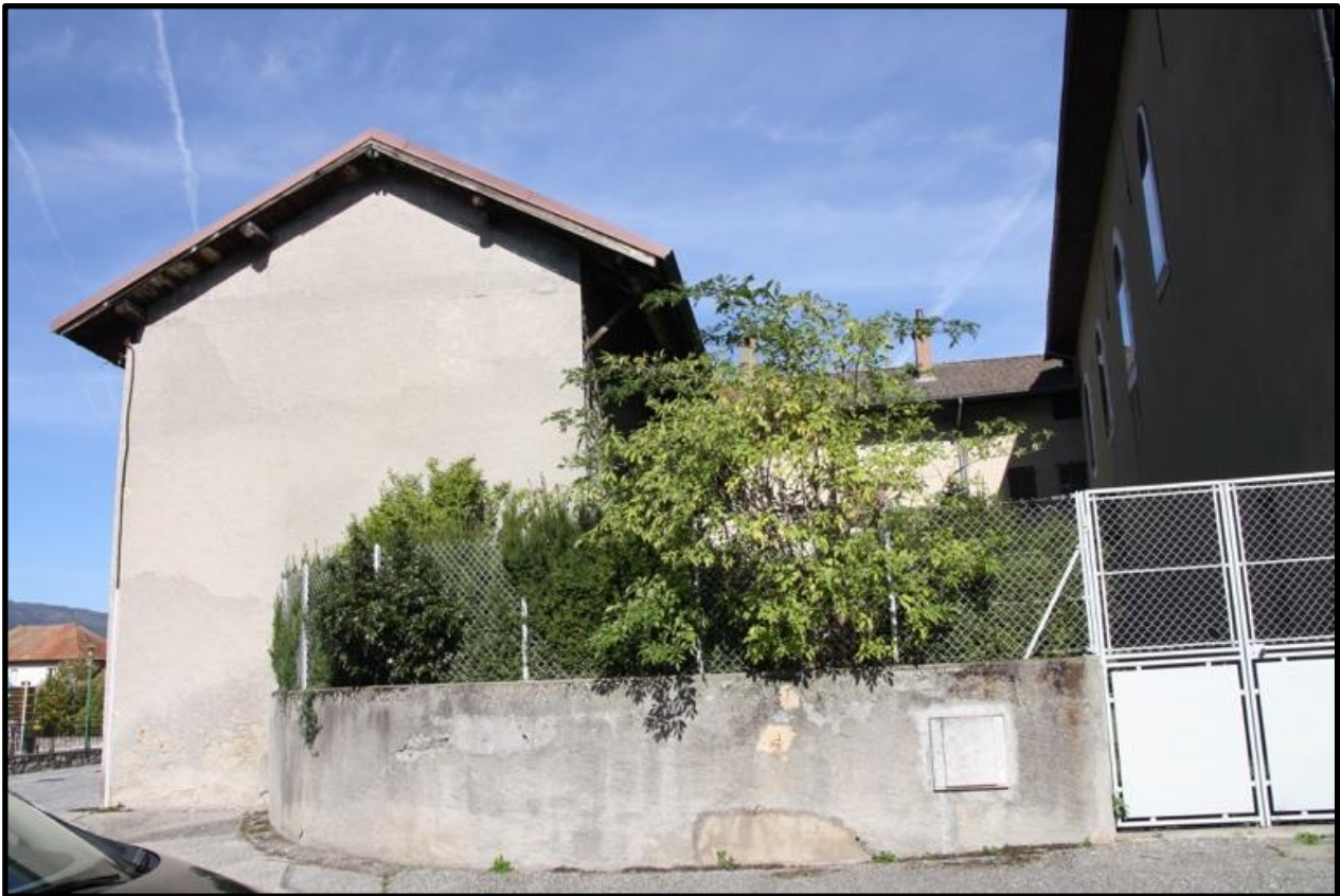
FAÇADE RUE DE L'ÉGLISE
