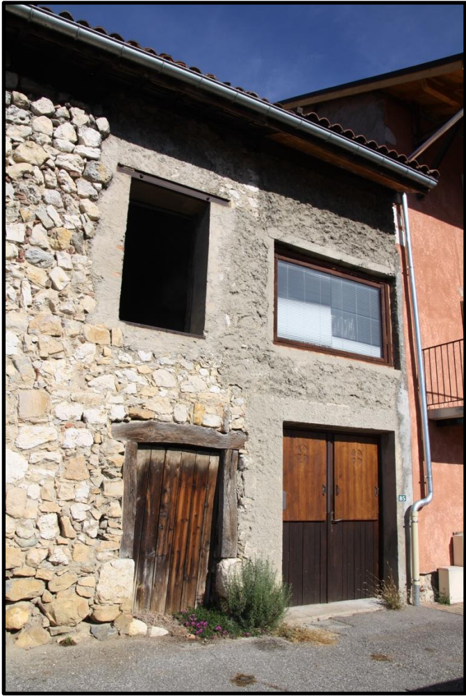
FAÇADE RUE DE L'ÉGLISE
