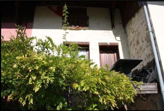
FAÇADE RUE DE L'ÉGLISE
