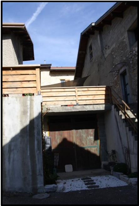
FAÇADE RUE DE L'ÉGLISE
