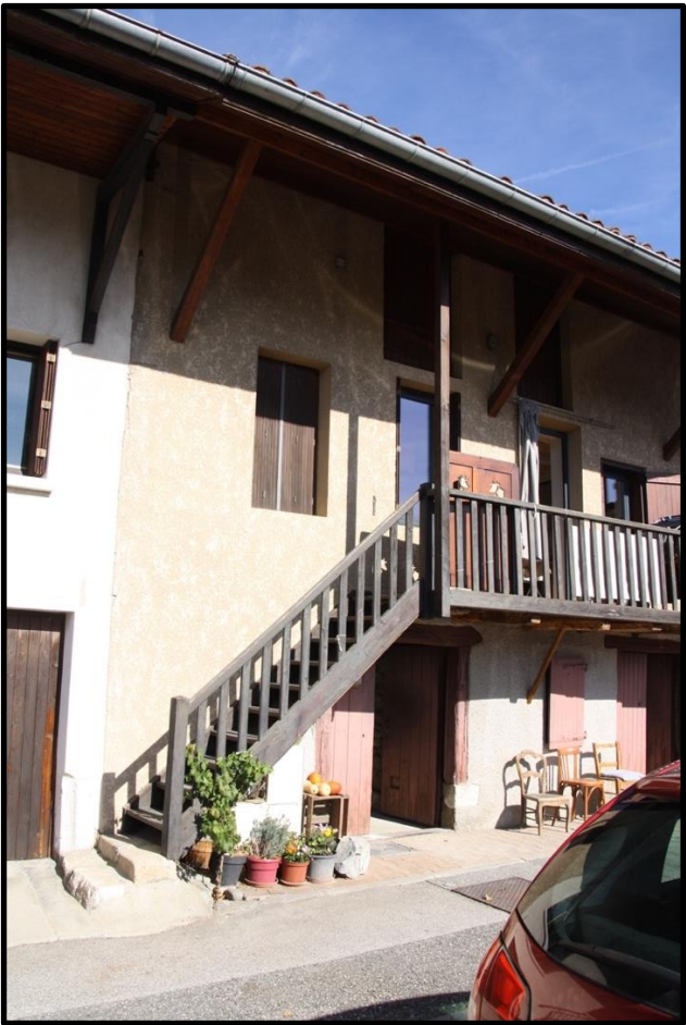
FAÇADE RUE DE L'ÉGLISE
