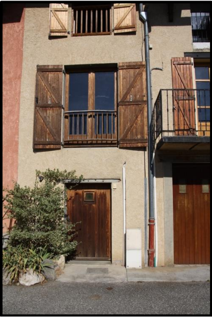
FAÇADE RUE DE L'ÉGLISE
