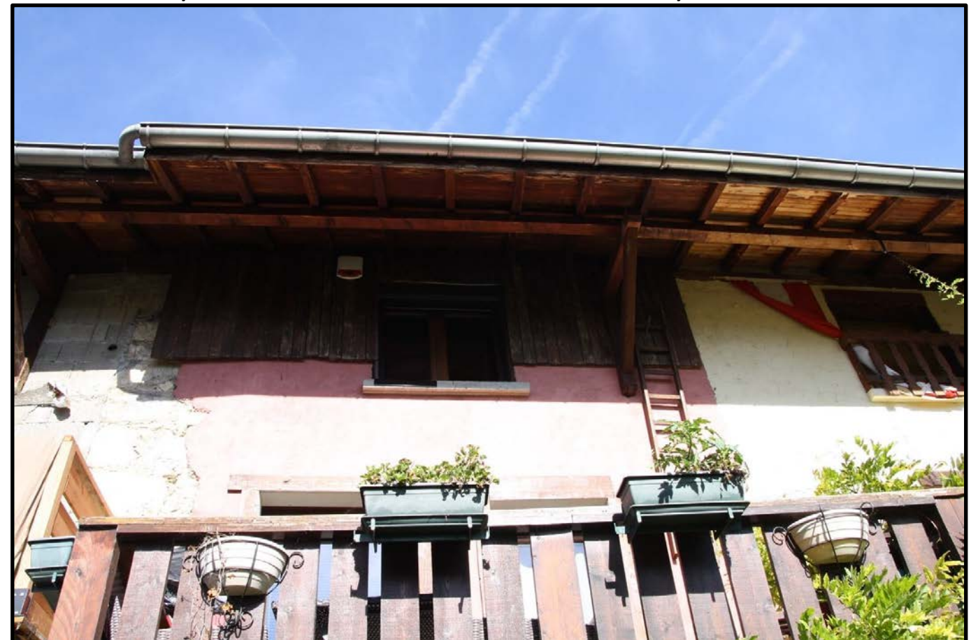
FAÇADE RUE DE L'ÉGLISE
