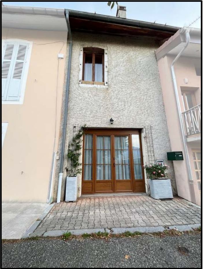
FAÇADE RUE DU BOURG
