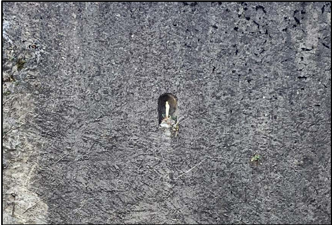
FAÇADE RUE DE L'ÉGLISE
