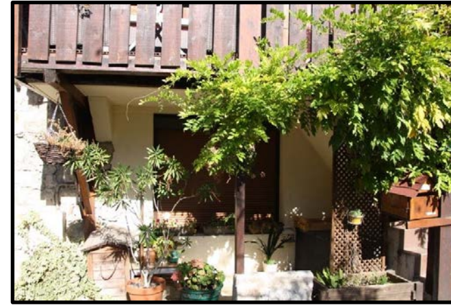
FAÇADE RUE DE L'ÉGLISE
