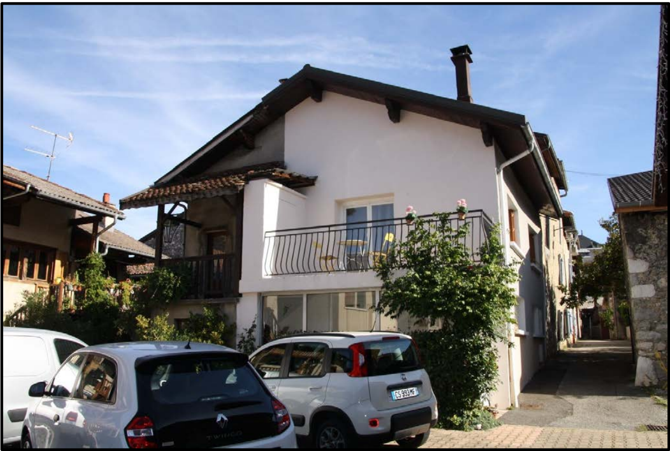
PROUE DE L’ÎLOT SEPARANT LA RUE COSTA DE BEAUREGARD DE LA RUE DU BOURG
