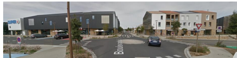
Opération mixte commerces/services en rez-de-chaussée et logements en étage - Bretignolles-sur-Mer, quartier des halles, agence Magnum
