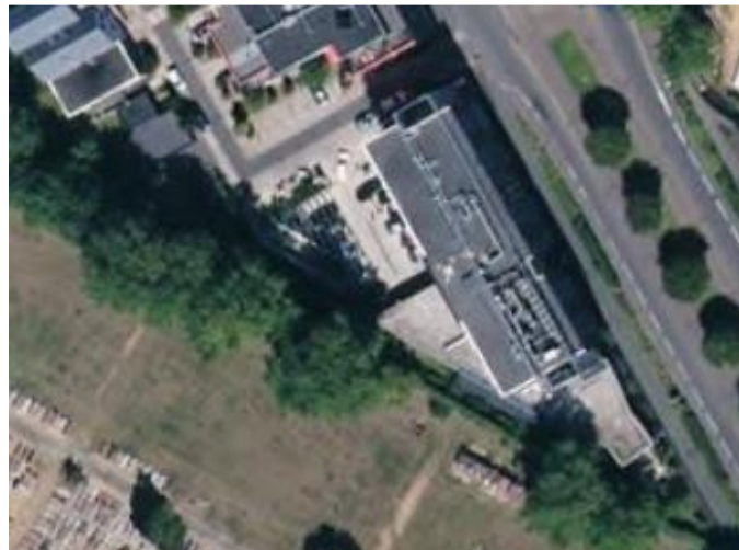
Implantation d'un hôtel-restaurant dans une bande de 30 m de profondeur, St Sébastien-sur-Loire (44)
