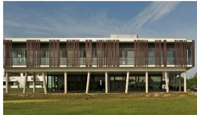
Densifier l'occupation au sol des zones : pilotis, réduction du nombre de stationnements...
